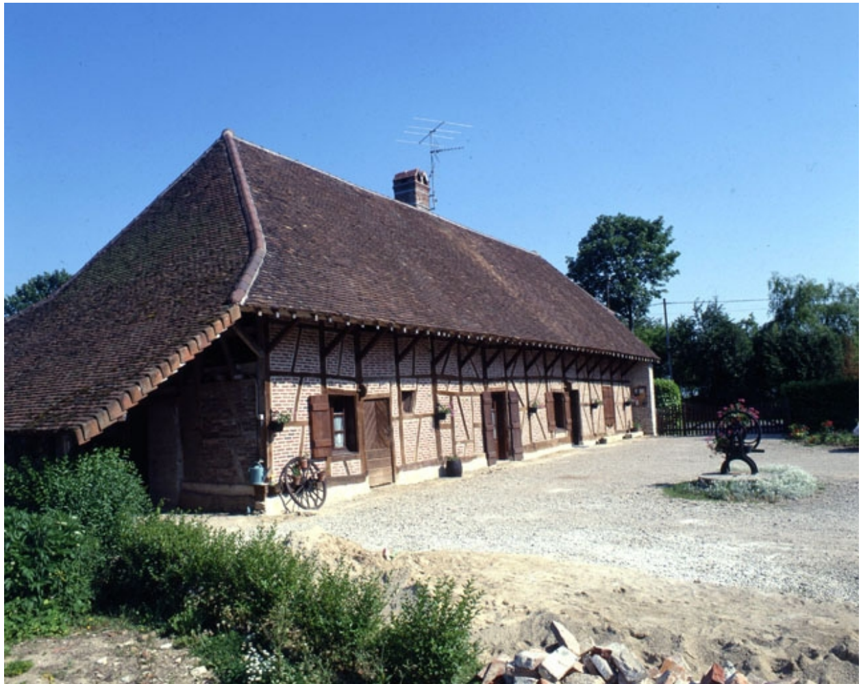
Bâtiment d'habitation : façade antérieure et cour en 1990.
