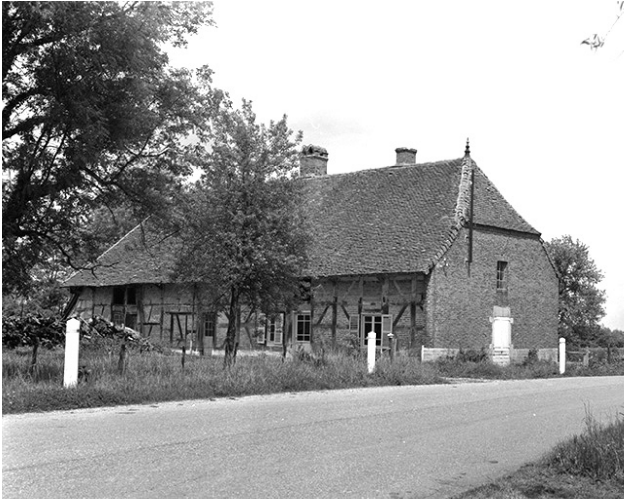
Bâtiment d'habitation en 1979.
