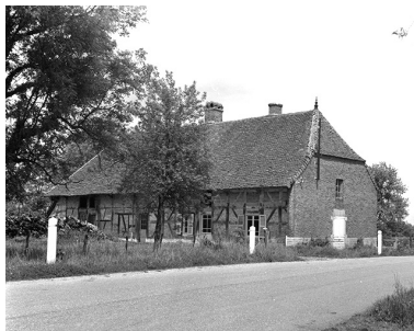
Bâtiment d'habitation en 1979. Phot. Bernard Lardière IVR43_19793900357X
