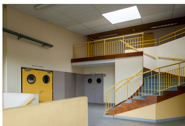
Détail de l'escalier intérieur de l'atelier. Phot. Jérôme Mongreville IVR43_20132501628NUC4A
