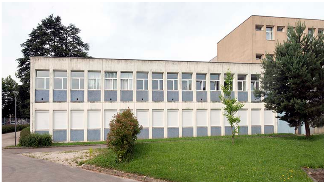
Façade nord-est du bâtiment d'internat et restauration.
