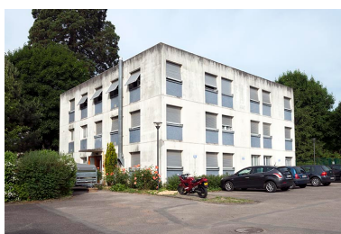
Angle sud des logements.
