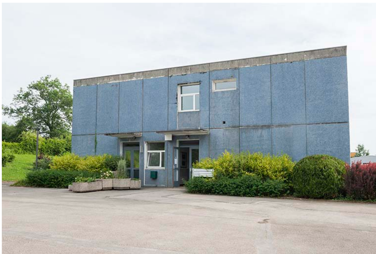
Détail du pignon sud-ouest de l'externat.
