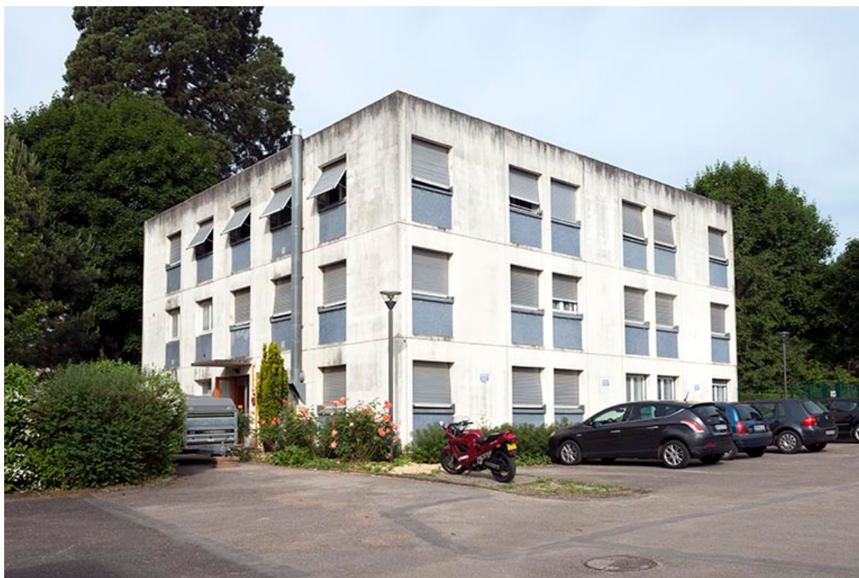
Angle sud des logements.
