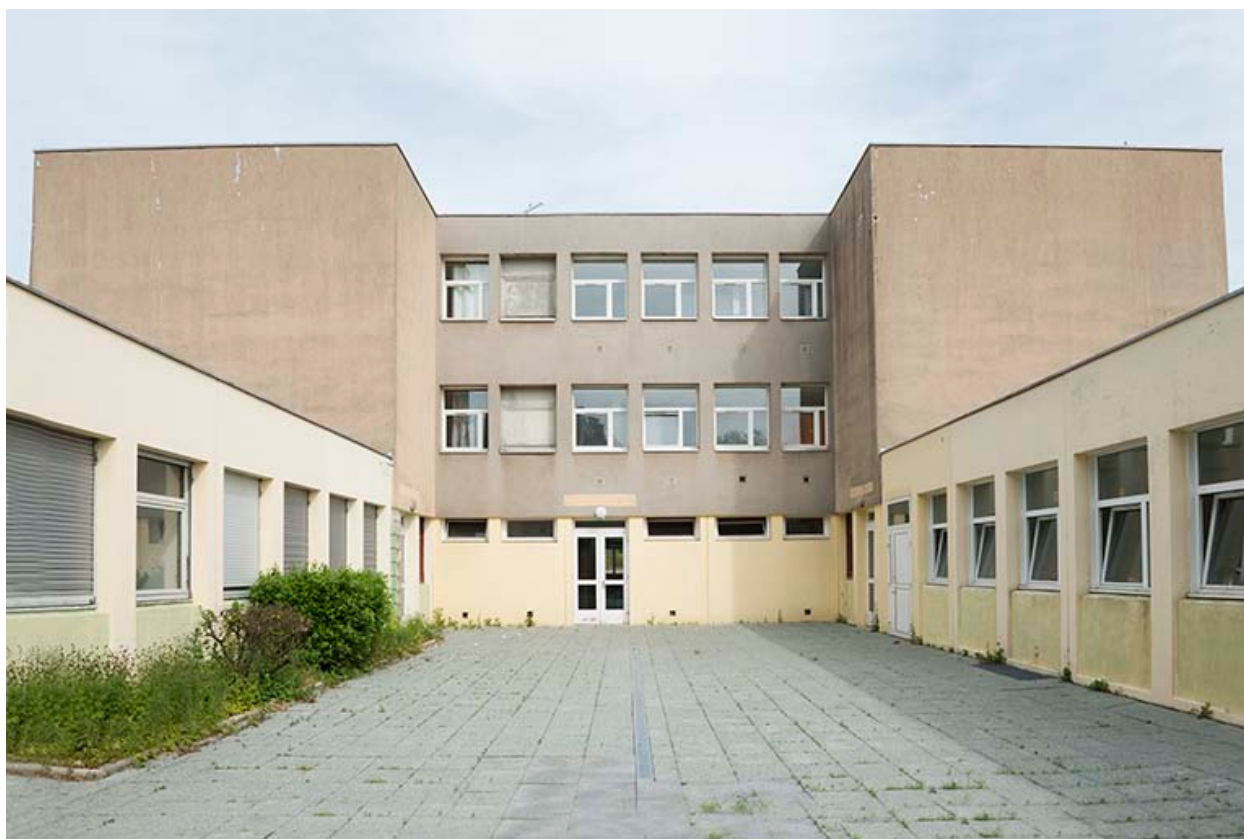
Cour postérieure du bâtiment d'internat et restauration.
