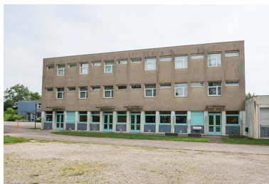
Façade sud-ouest de l'internat restauration.
