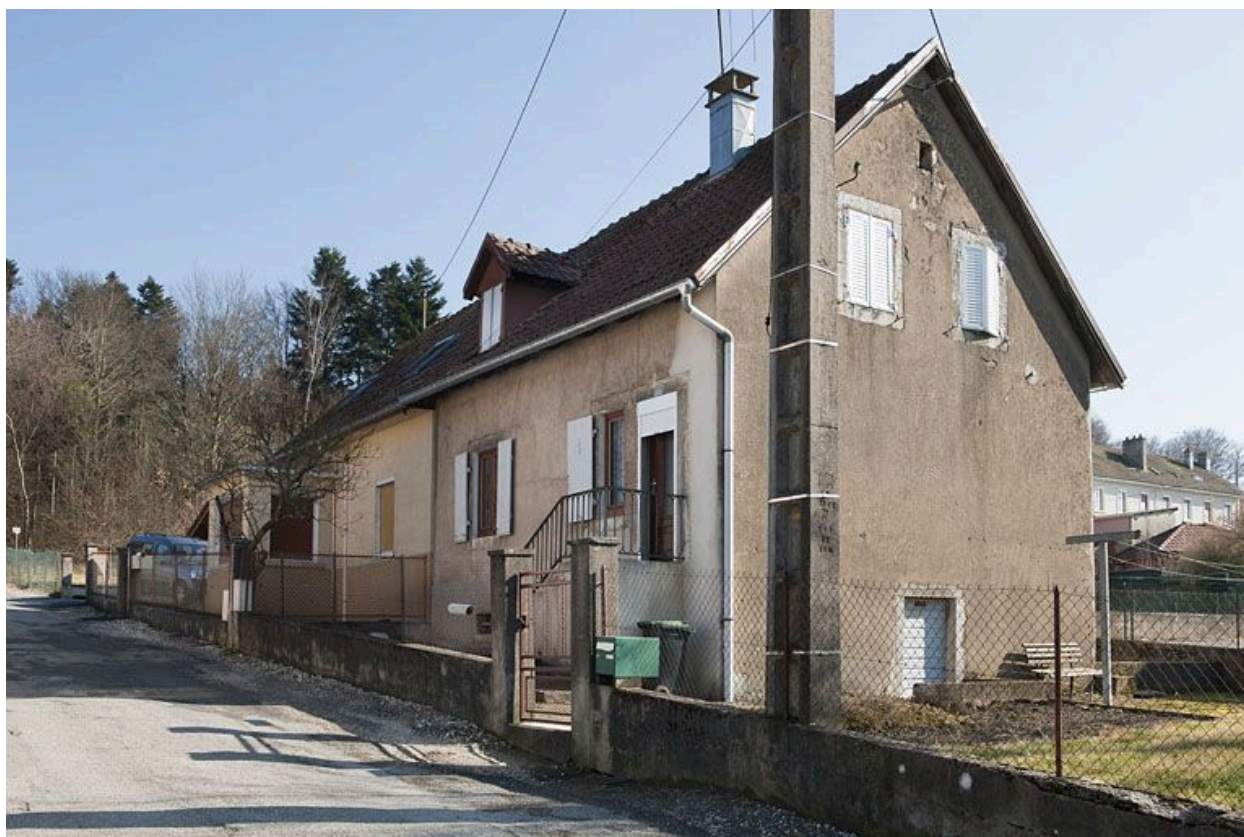
Maison jumelée rue d'Alsace.
