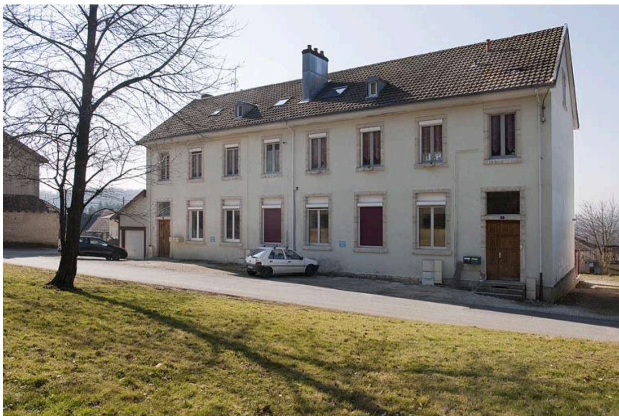
Ecole. Façade est.
