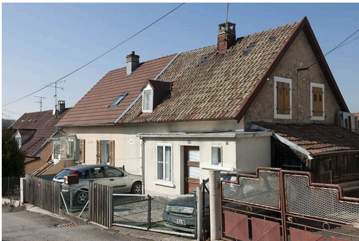
Maison jumelée rue d'Alsace.
