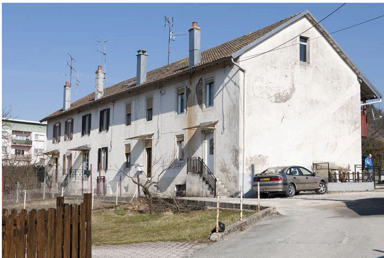
Habitation à 8 logements (?) rue du Nègre.
