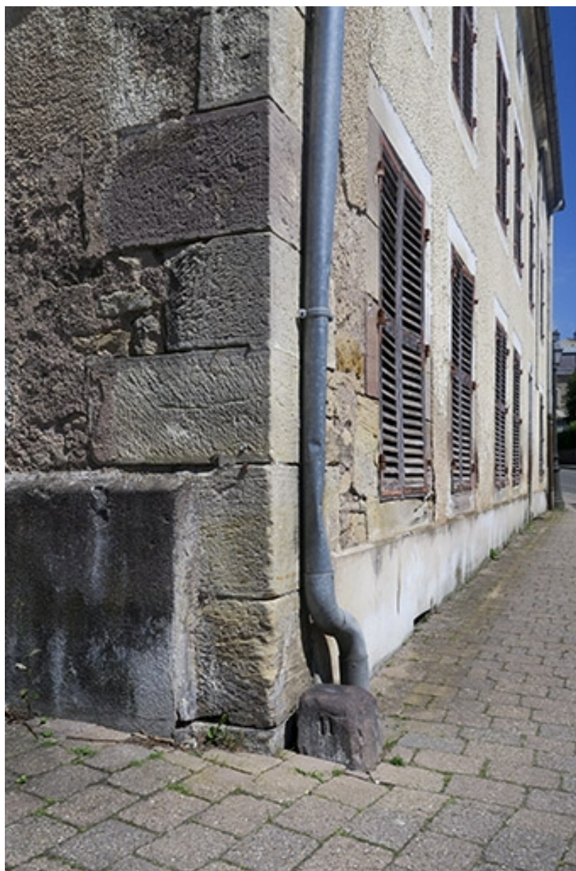
Vue de la borne à l'angle de la rue Jean Jaurès et de la rue de la Saline.
