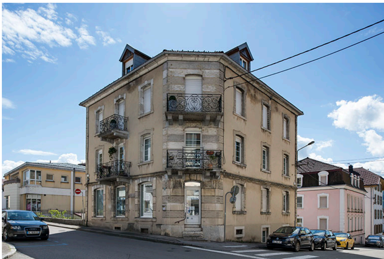
Vue d'ensemble, sur le pan coupé.
