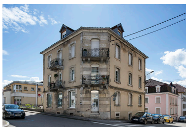
Vue d'ensemble, sur le pan coupé. Phot. Sonia Dourlot IVR43_20182500706NUC4A
