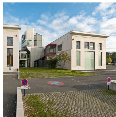
Vue extérieure, façade postérieure. Phot. Pierre-Marie Barbe-Richaud IVR26_20107100680NUC4A
