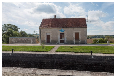
Maison éclusière vue de face.
