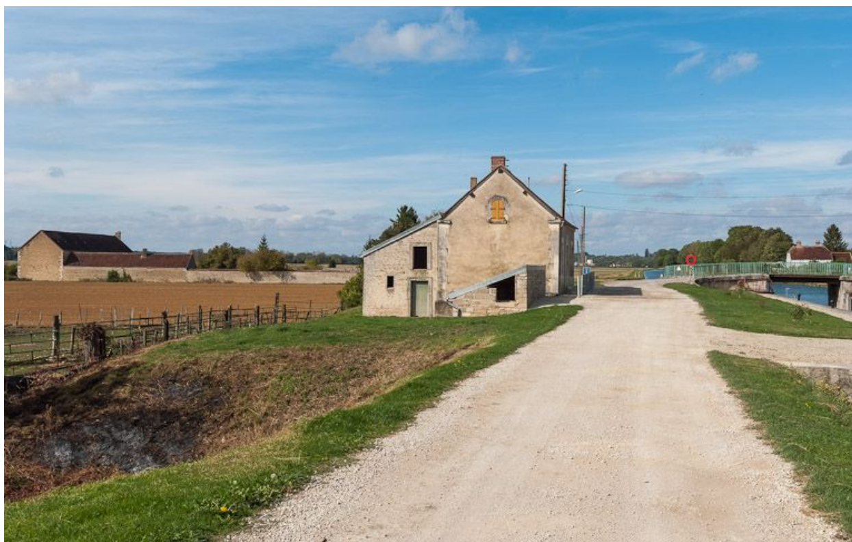
La maison éclusière avec ses appentis.
