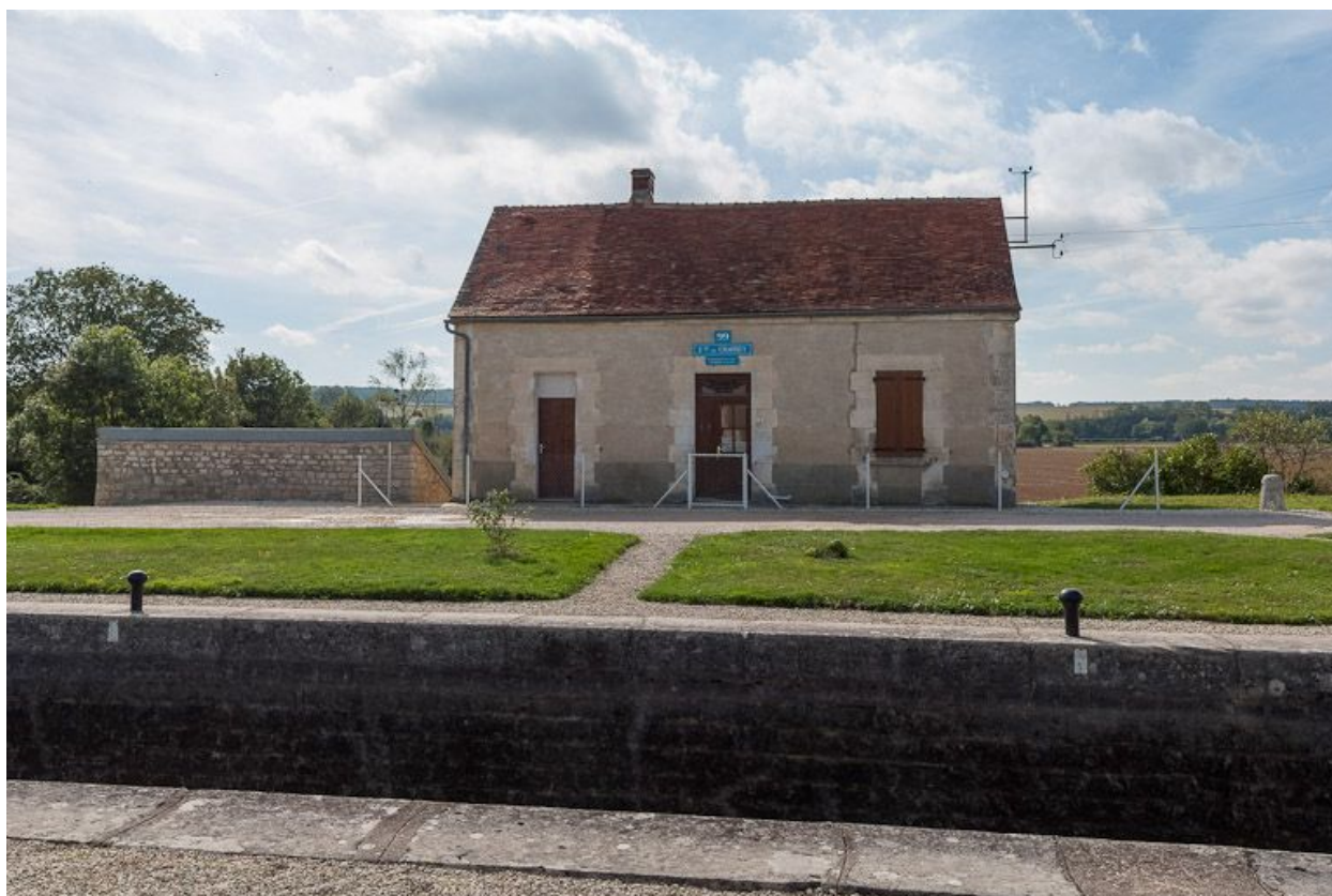
Maison éclusière vue de face.
