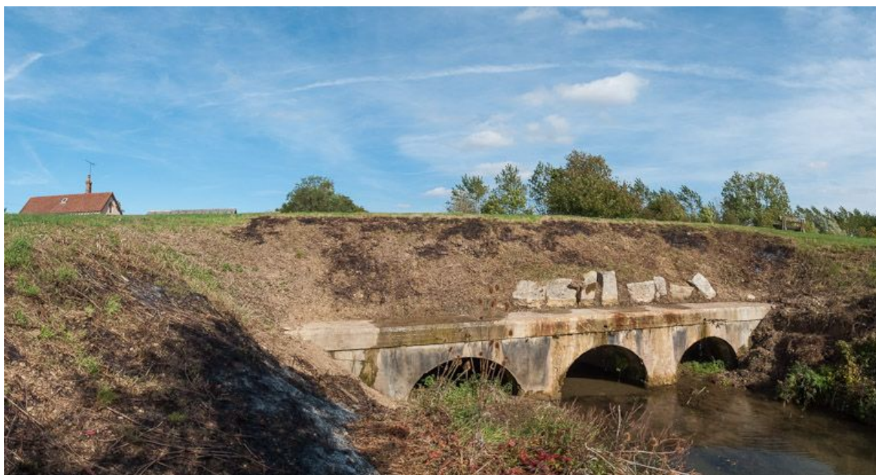
Aqueduc en amont du sas.
