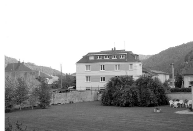
Façade latérale droite du bureau. Phot. Laurent Poupard IVR43_19913901296Z
