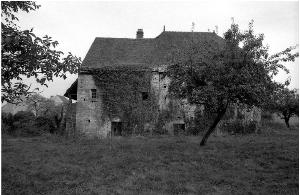
Façade latérale droite.
