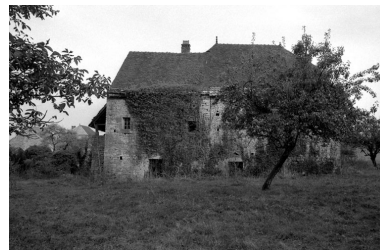
Façade latérale droite. Phot. Bernard Lardière IVR43_19797000053Z
