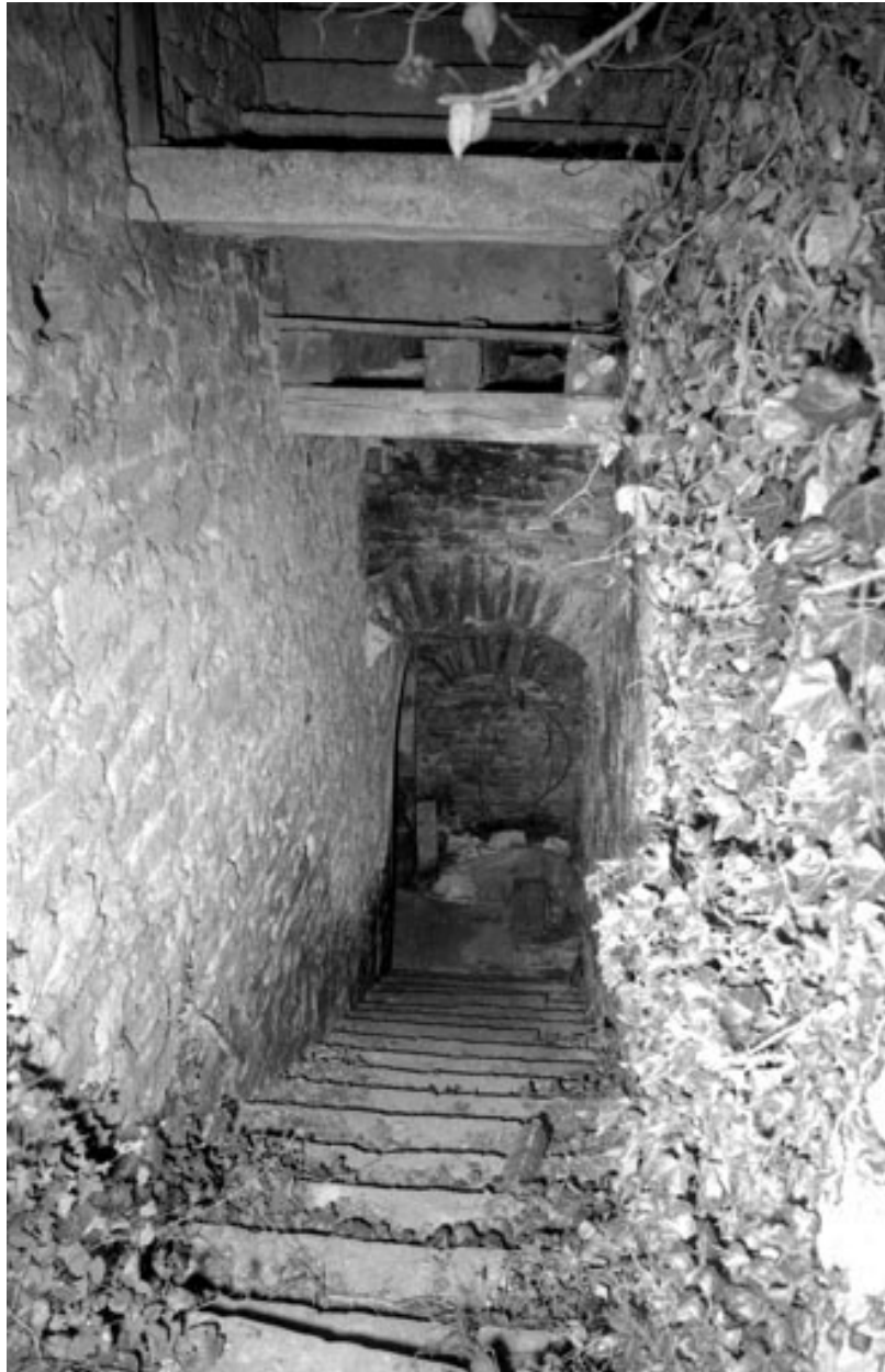
Partie habitation : escalier menant à la cave.
