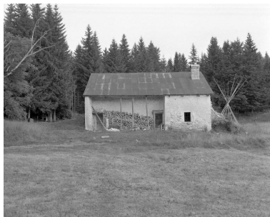
Ferme située au lieu- dit La Perrière Sud. Phot. Jérôme Mongreville IVR43_19943900762X
