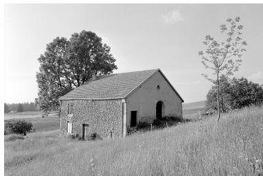
Ferme située au lieu-dit Au Reculet Phot. Jérôme Mongreville IVR43_19943900770X
