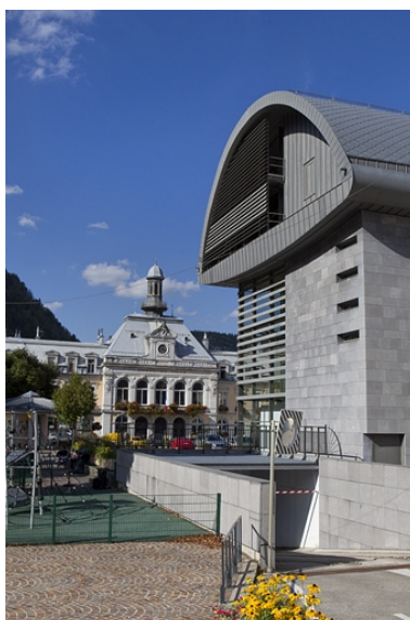
Façade latérale droite. Phot. Yves Sancey IVR43_20103900596NUC2A
