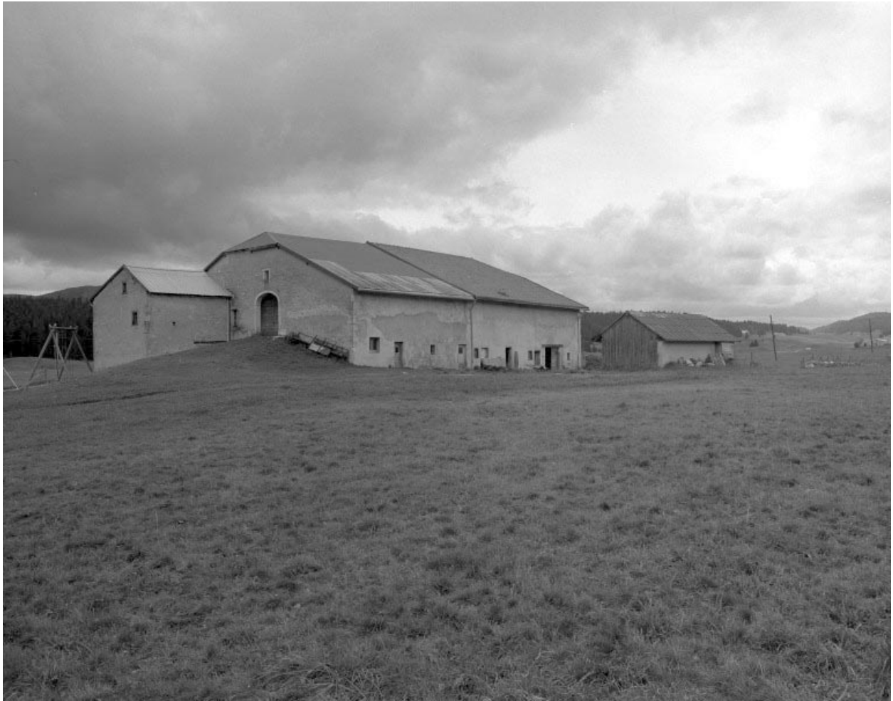
Façade postérieure des deux fermes mitoyennes.
