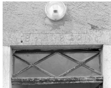
Le linteau de la porte d'entrée. Phot. Jérôme Mongreville IVR43_19943900904X
