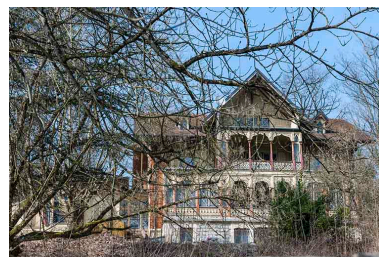
Façade sud du logement patronal. Phot. Jérôme Mongreville
