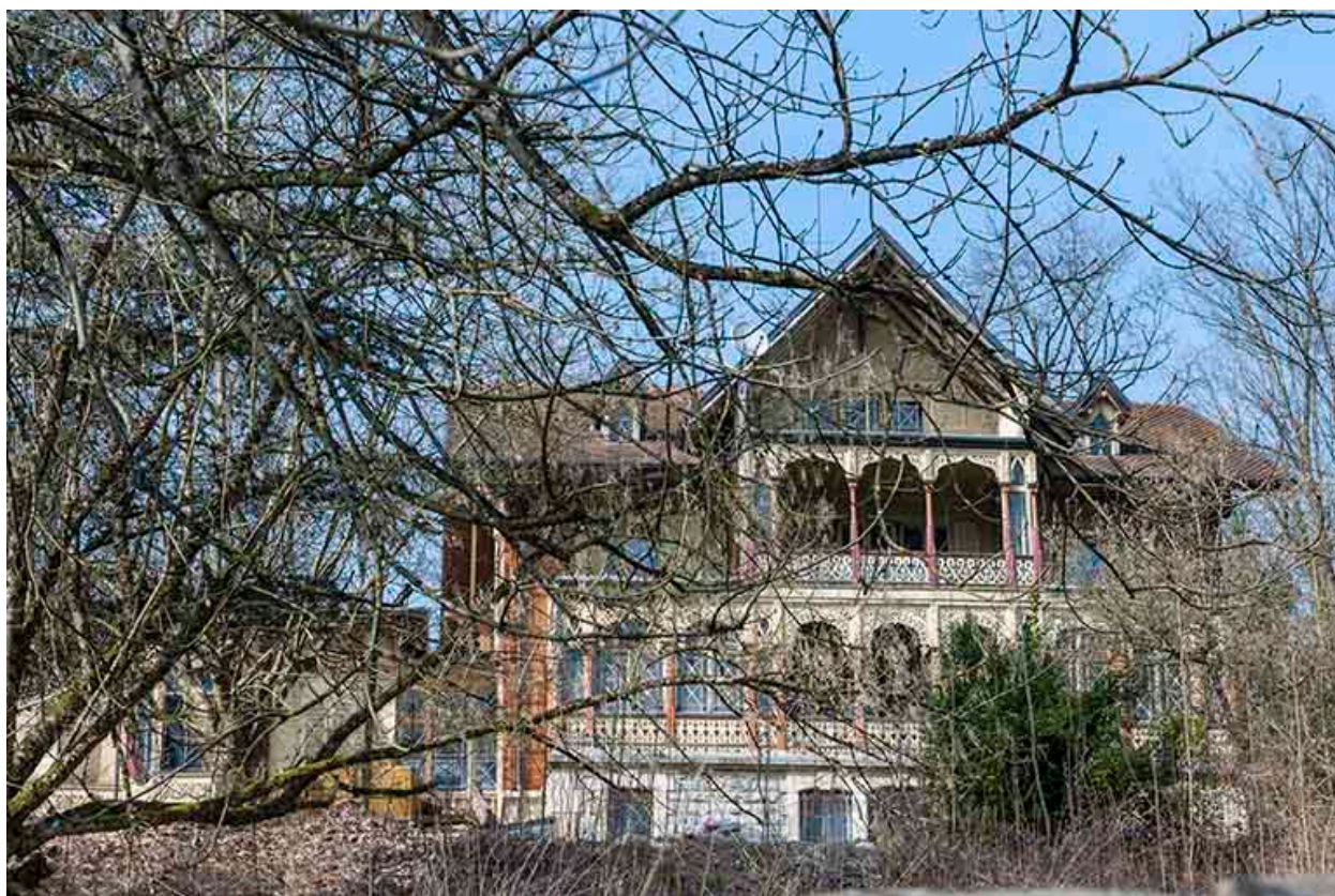
Façade sud du logement patronal.
