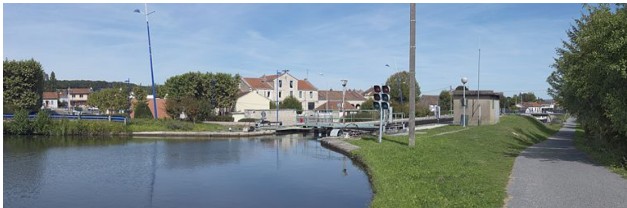
Vue d'ensemble prise d'amont du bord du canal à Écuisses avec la mairie et le site d'écluse 04.
