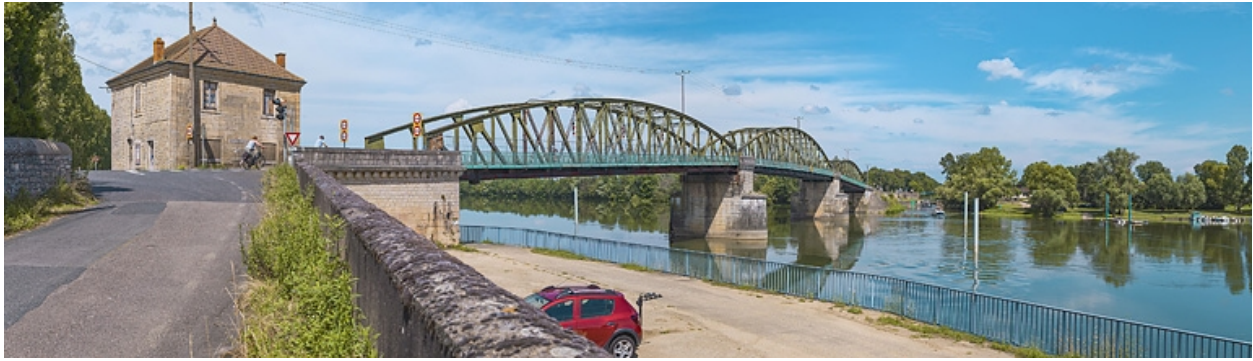
Le pont de Fleurville, vu d'aval, depuis la rive droite. La maison pontière se trouve au premier plan.
