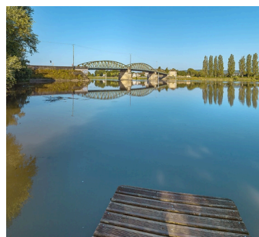
Le pont de Fleurville, vu d'amont et depuis la rive gauche. Phot. Thierry Kuntz IVR26_20217100510NUC4A
