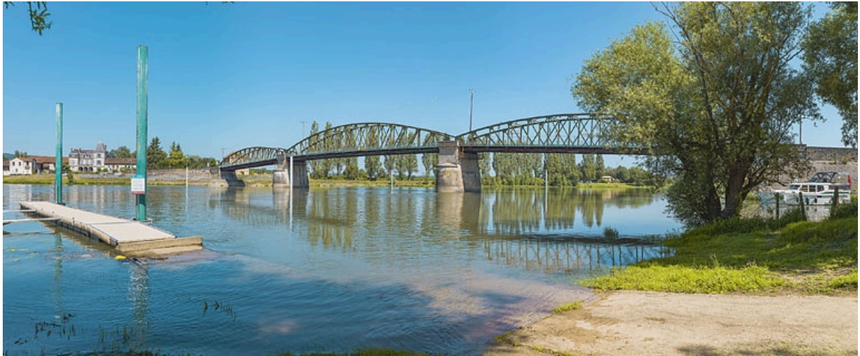
Le pont de Fleurville, vu d'aval, depuis la rive gauche.
