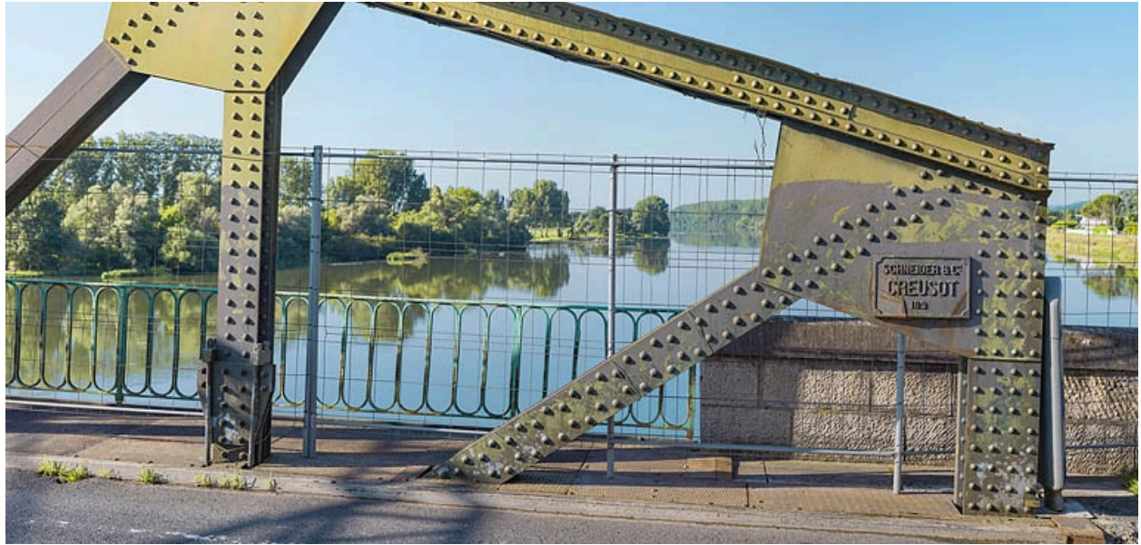
Détail de la structure métallique du pont et de la plaque "Schneider et Cie".
