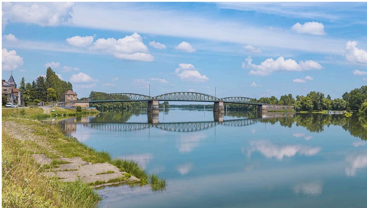
Le pont de Fleurville, vu d'aval, depuis la rive droite.
