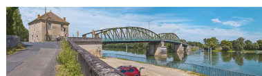
Le pont de Fleurville, vu d'aval, depuis la rive droite. La maison pontièrse trouve au premier plan. Phot. Thierry Kuntz IVR26_20217100523NUC4A
