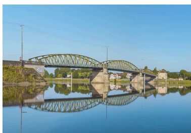
Le pont de Fleurville, vu d'amont, depuis la rive gauche. Phot. Thierry Kuntz IVR26_20217100509NUC4A
