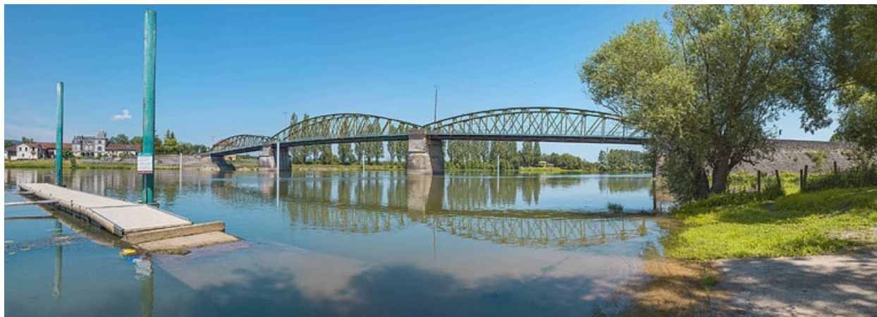
Le pont de Fleurville, vu d'aval, depuis la rive gauche.
