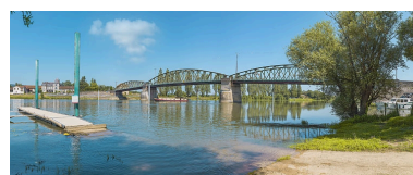
Le pont de Fleurville, vu d'aval, depuis la rive gauche. Phot. Thierry Kuntz IVR26_20217100520NUC4A
