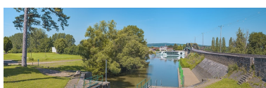
Le pont et le port de Fleurville vus depuis l'entrée du canal de Pont de Vaux, rive gauche. Phot. Thierry Kuntz IVR26_20217100512NUC4A
