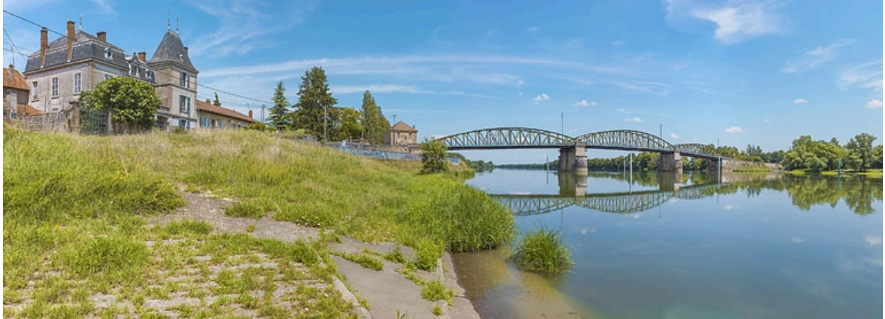
Le port à gradins de Fleurville, sur la rive droite. En arrière-plan le pont de Fleurville.
