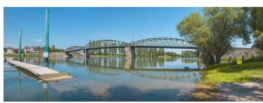
Le pont de Fleurville, vu d'aval, depuis la rive gauche. Phot. Thierry Kuntz IVR26_20217100519NUC4A
