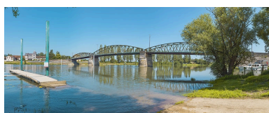
Le pont de Fleurville, vu d'aval, depuis la rive gauche. Phot. Thierry Kuntz IVR26_20217100521NUC4A
