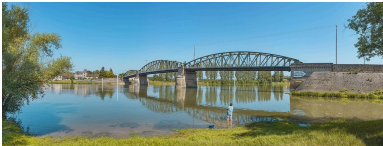
Le pont de Fleurville, vu d'aval, depuis la rive gauche.
