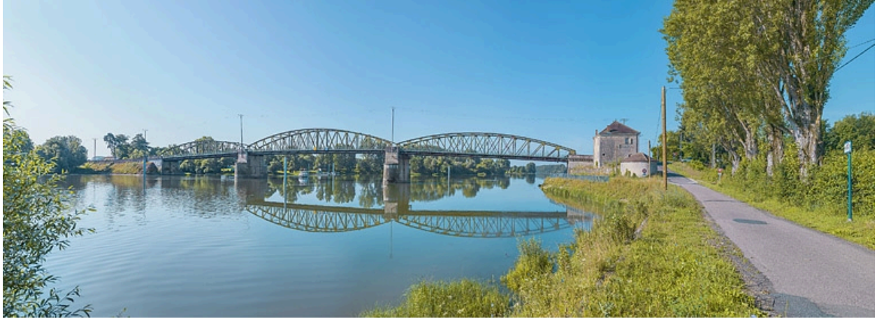
Le pont de Fleurville, vu d'amont, depuis la rive droite.
