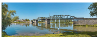
Le pont de Fleurville, vu d'aval, depuis la rive gauche. Phot. Thierry Kuntz IVR26_20217100518NUC4A
