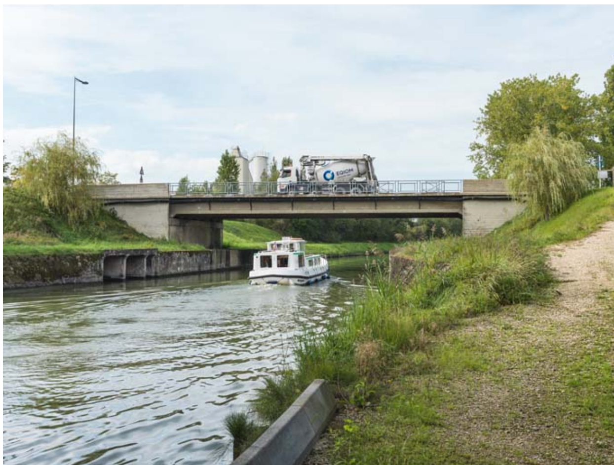
Vue d'ensemble du pont.
