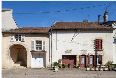
Les n° 27 et 29 de la rue Thiers. Phot. Jérôme Mongreville IVR43_20217000341NUC4A
