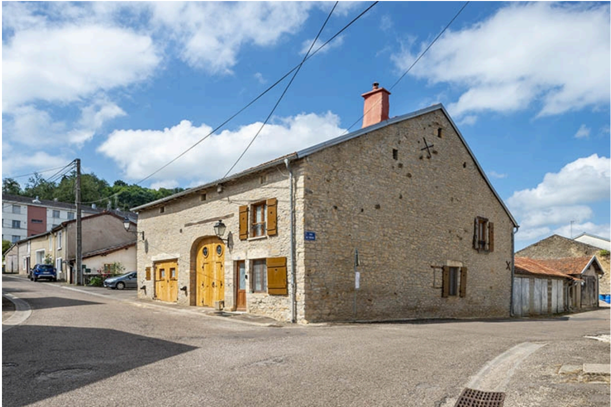
Le n° 30 de la rue du parlement, vue d'ensemble.
