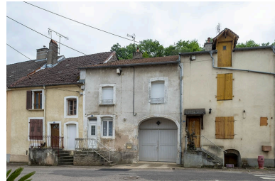
Les n° 36, 38 et 40 de la rue Thiers. Phot. Jérôme Mongreville IVR43_20217000345NUC4A
