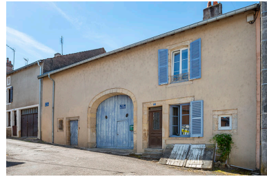
Le n° 23 rue Rech, de trois quarts droit. Phot. Jérôme Mongreville IVR43_20217000572NUC4A
