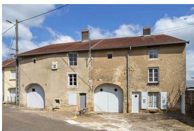
Les n° 21 et 23 rue de l'Aître, de face. Phot. Jérôme Mongreville IVR43_20217000507NUC4A
