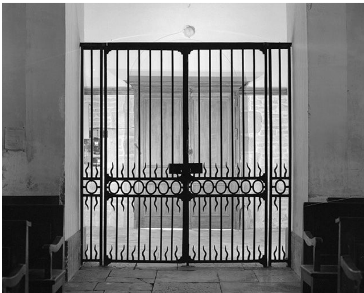
Clôture de chapelle : vue d'ensemble.
