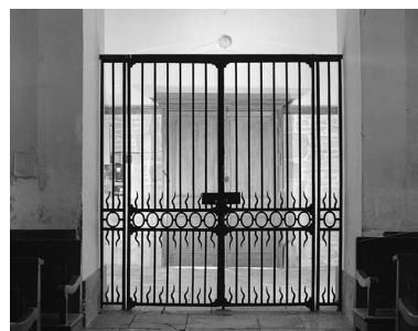
Clôture de chapelle : vue d'ensemble. Phot. Yves Sancey IVR43_19757000066X
