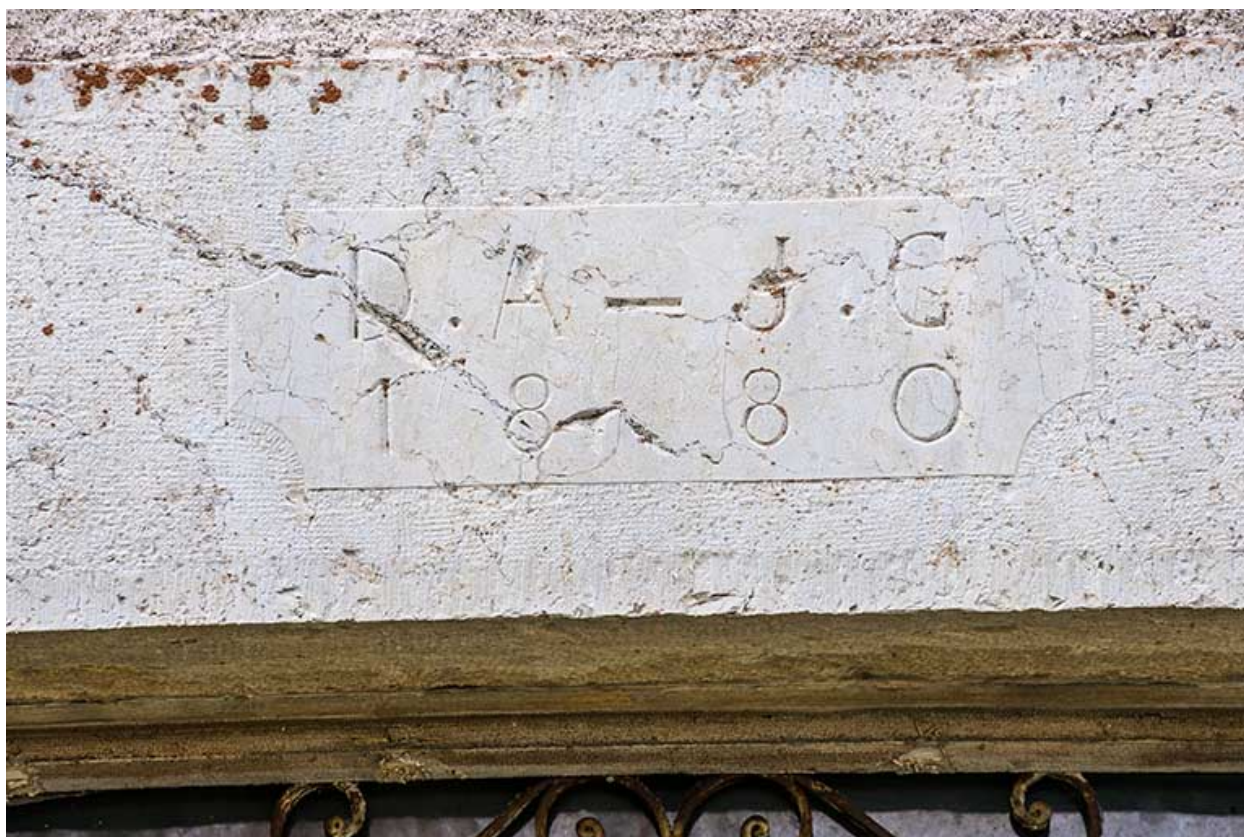
Entrée principale : linteau daté.
