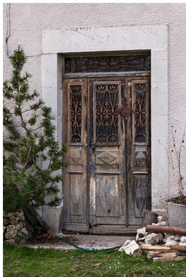
Entrée principale. Phot. Jérôme Mongreville IVR43_20142500188NUC4A
