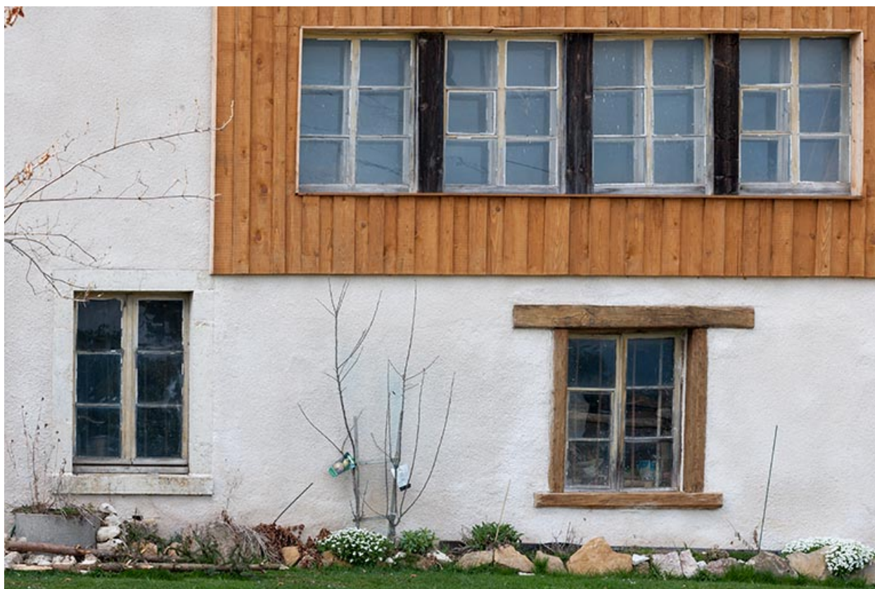
Fenêtres multiples de l'atelier.
