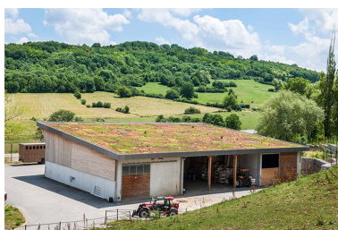
Centre équestre : hangar Phot. Jérôme Mongreville IVR43_20143900562NUC4A
