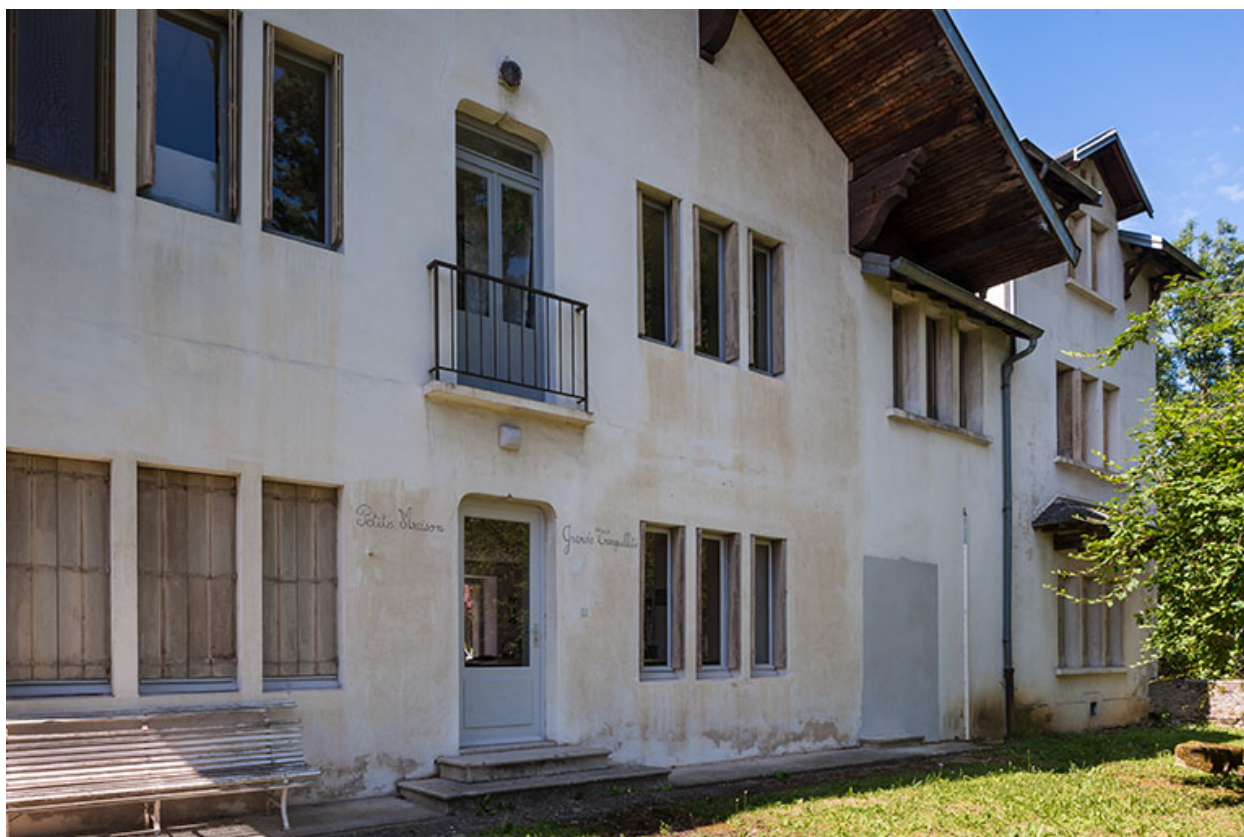
Chalet Colette : façade postérieure.
