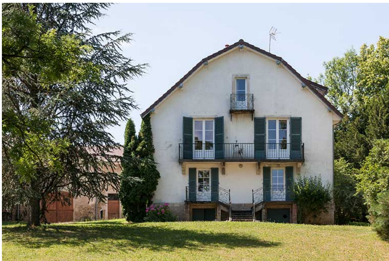
Pavillon du proviseur : façade antérieure.
