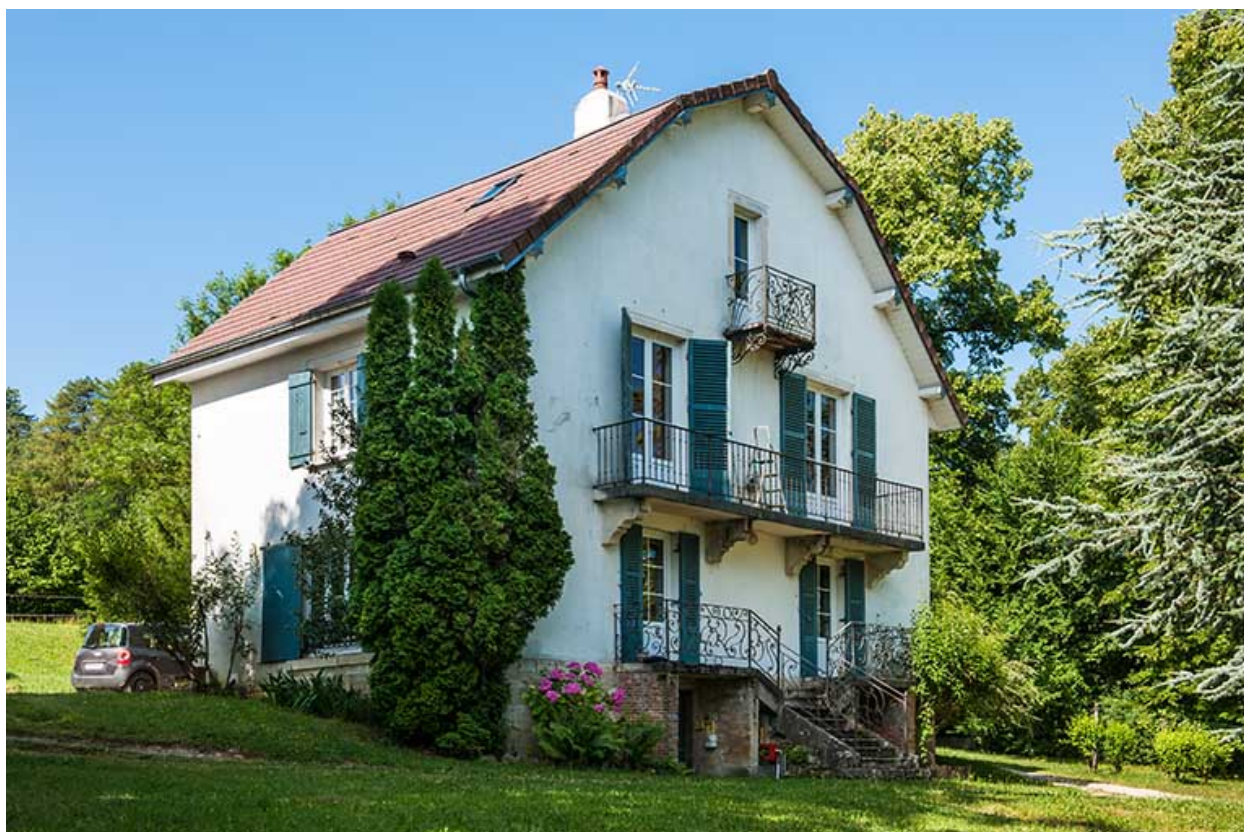
Pavillon du proviseur, vue trois quart.
