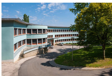
Internat : vue sud. Phot. Jérôme Mongreville IVR43_20143900525NUC4A
