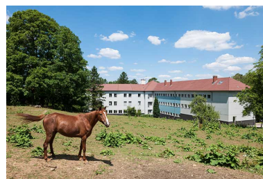
Externat : façade postérieure. Phot. Jérôme Mongreville IVR43_20143900519NUC4A
