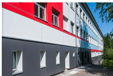
Externat : façade antérieure avec parements isolants de couleur. Phot. Jérôme Mongreville IVR43_20143900517NUC4A
