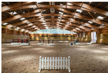
Centre équestre : manège, vue intérieure avec charpente en lamellé collé. Phot. Jérôme Mongreville IVR43_20143900560NUC4A
