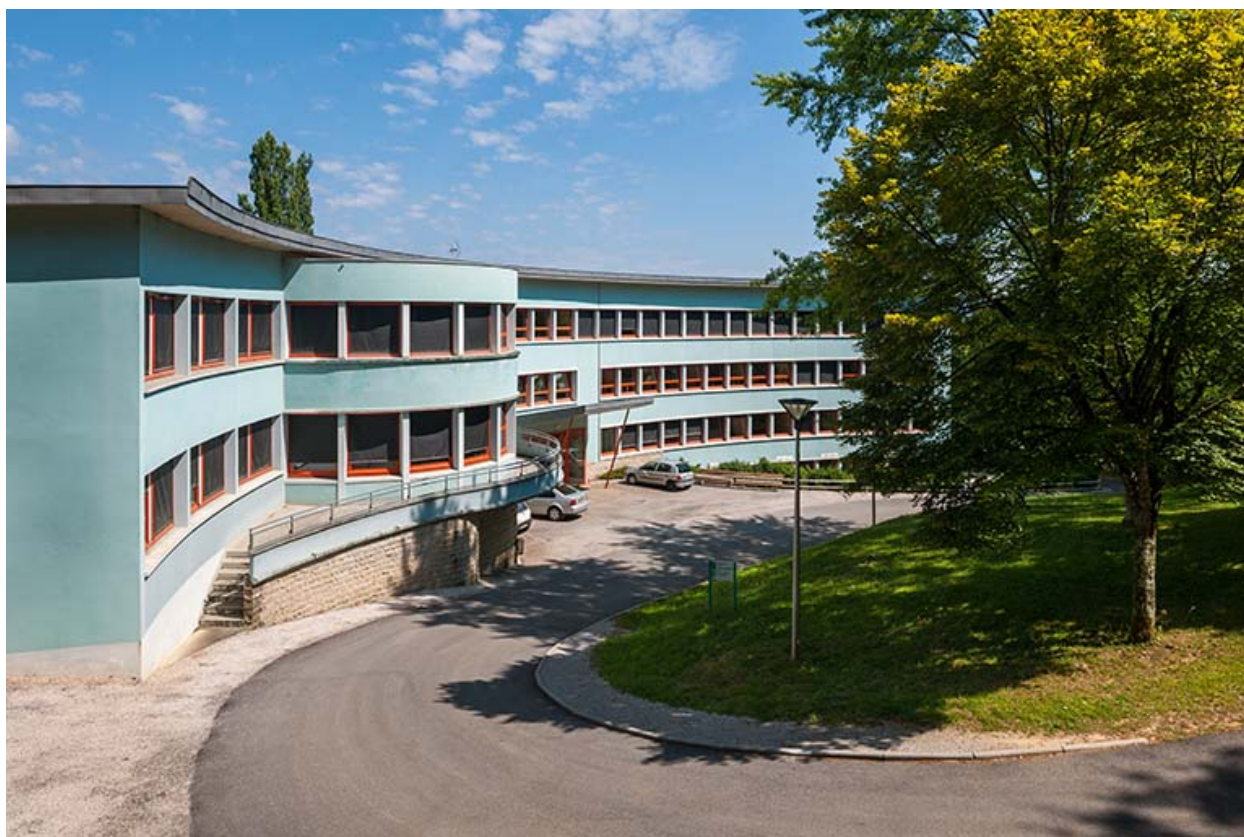
Internat : vue sud.
