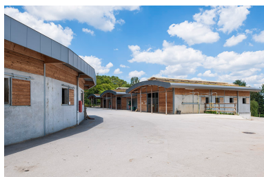
Centre équestre : ensemble des boxes. Phot. Jérôme Mongreville IVR43_20143900553NUC4A
