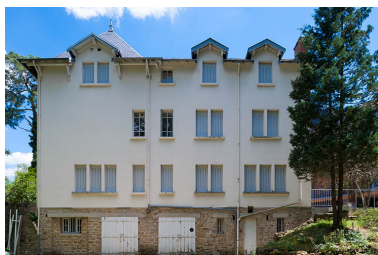
Chalet Colette : façade postérieure de l'aile ouest. Phot. Jérôme Mongreville IVR43_20143900514NUC4A
