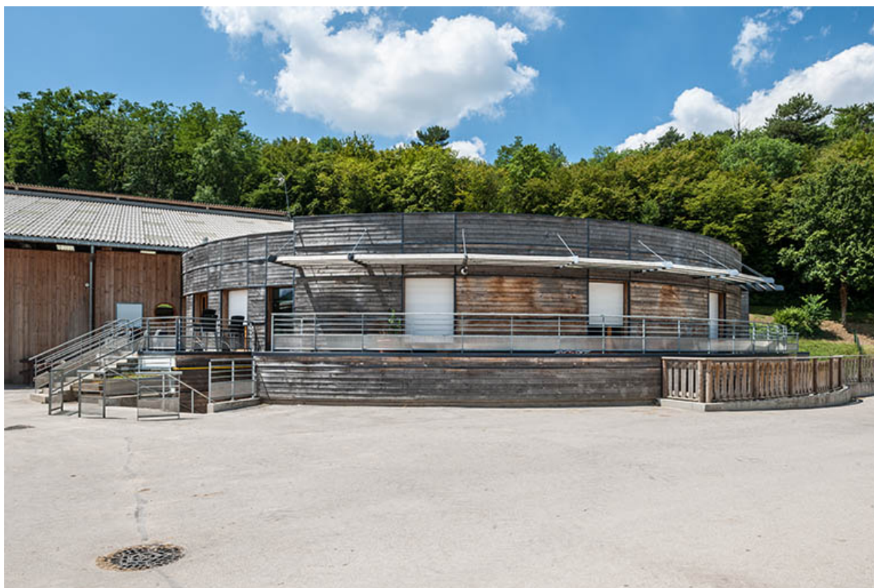
Centre équestre : rotonde du bâtiment d'accueil.
