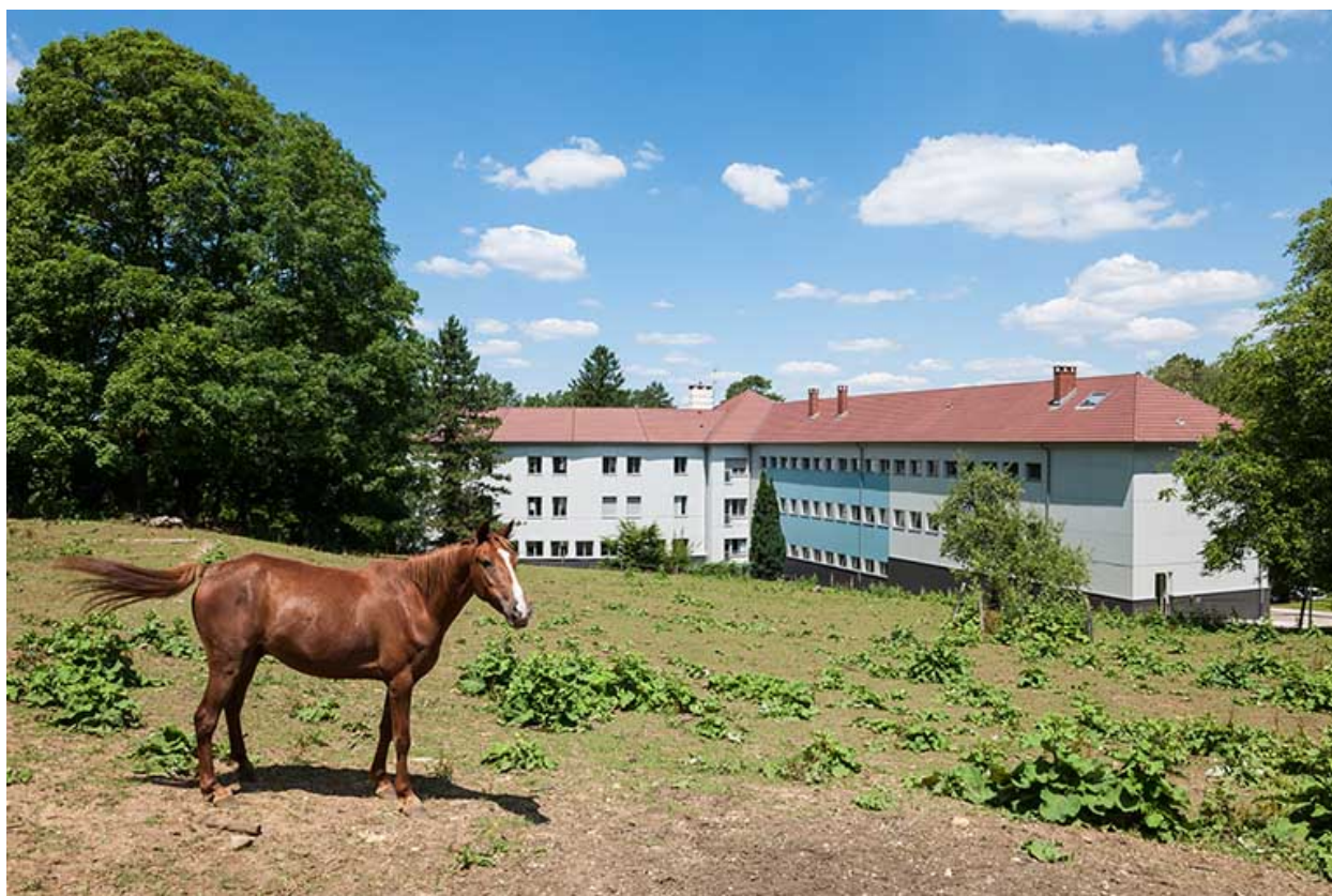
Externat : façade postérieure.
