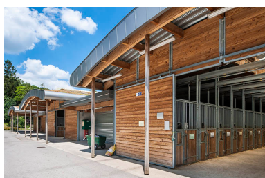
Centre équestre : boxes d'enseignement. Phot. Jérôme Mongreville IVR43_20143900556NUC4A
