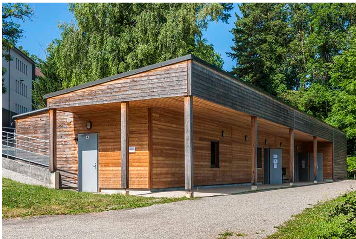
Externat : façade antérieure du préfabriqué rénové.
