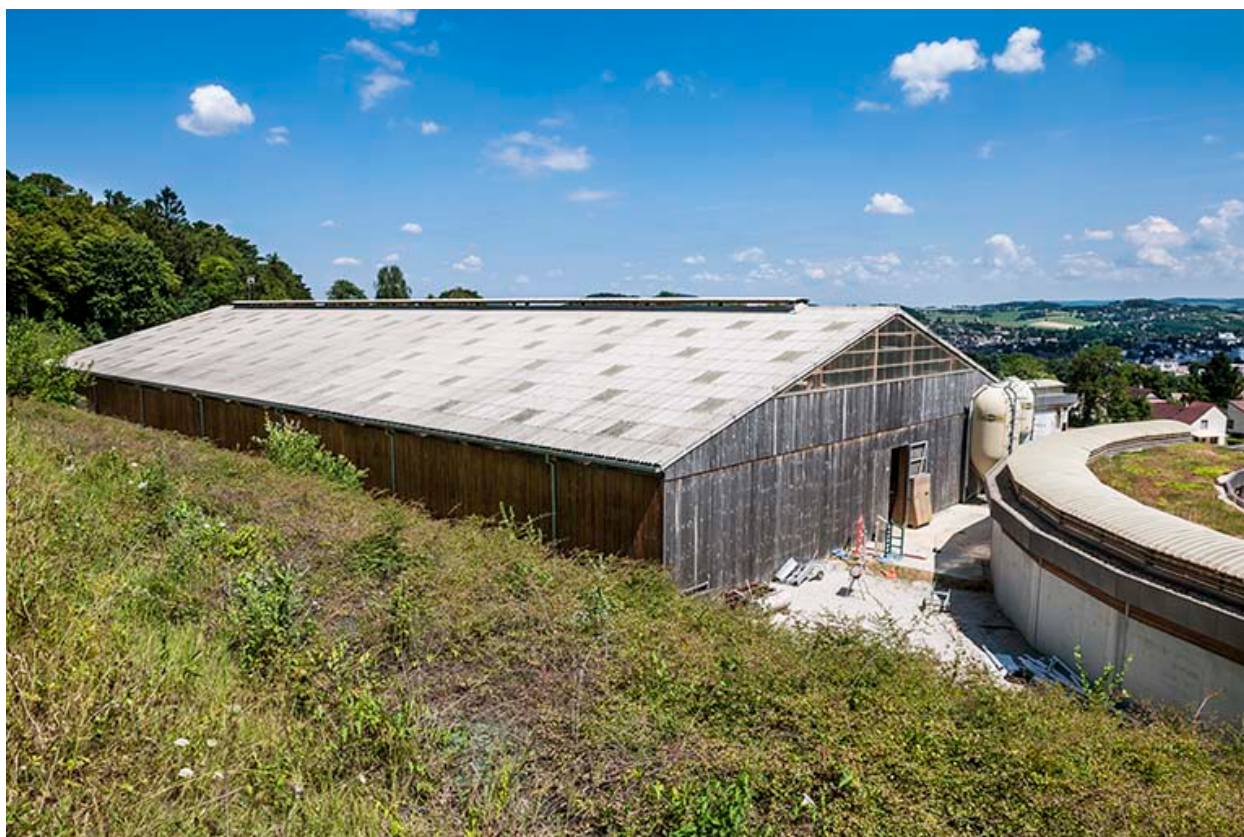
Centre équestre : toiture du manège.
