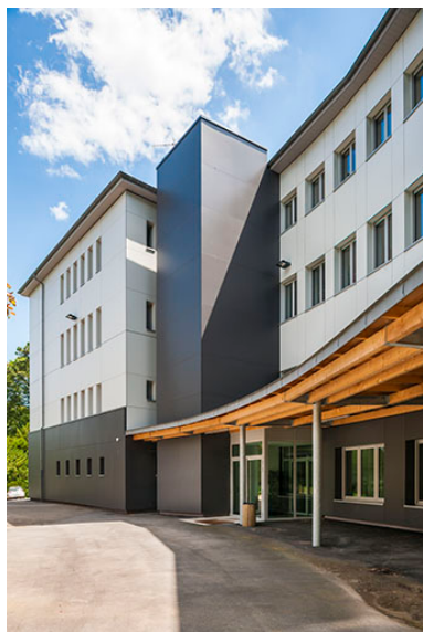
Externat, façade postérieure : détail. Phot. Jérôme Mongreville IVR43_20143900521NUC4A
