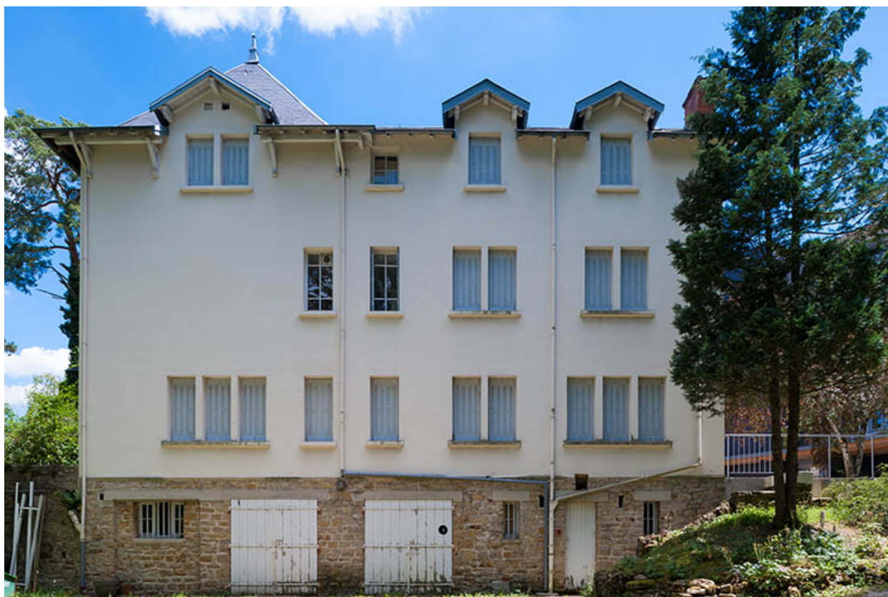
Chalet Colette : façade postérieure de l'aile ouest.
