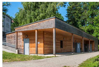
Externat : façade antérieure du préfabriqué rénové. Phot. Jérôme Mongreville IVR43_20143900512NUC4A
