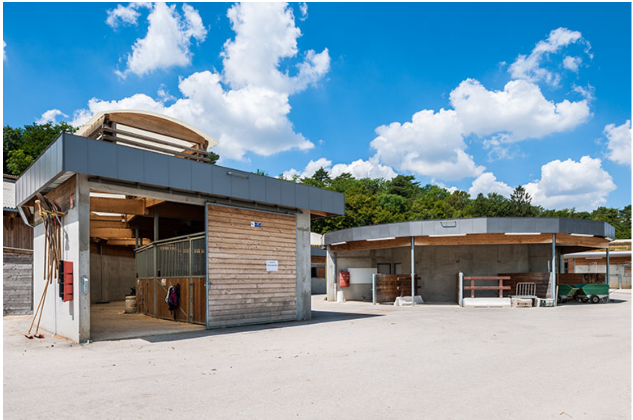
Centre équestre : détails des installations des propriétaires.
