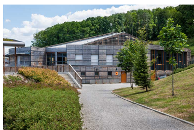
Centre équestre : manège, accès et bâtiment d'accueil. Phot. Jérôme Mongreville
