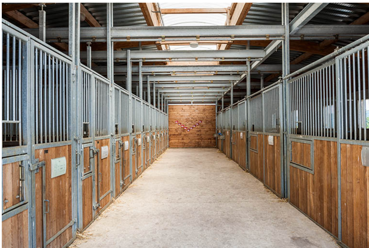
Centre équestre : boxes d'enseignement, allée centrale.
