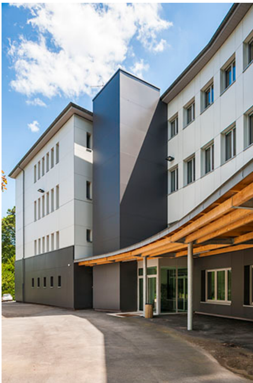
Externat, façade postérieure : détail.
