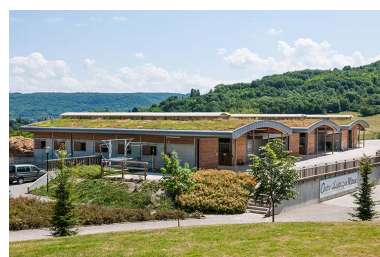
Centre équestre : vue générale des boxes d'enseignement. Phot. Jérôme Mongreville IVR43_20143900541NUC4A
