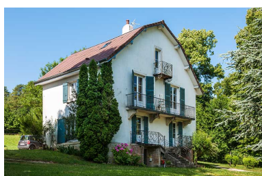
Pavillon du proviseur, vue trois quart.
