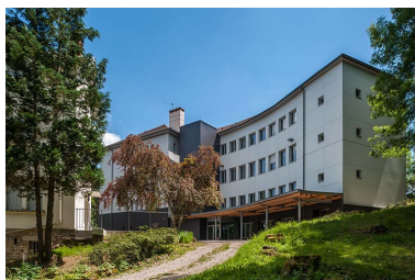
Externat : aile ouest, façade postérieure après rénovation , ajout d'un auvent et parements isolants. Phot. Jérôme Mongreville IVR43_20143900520NUC4A
