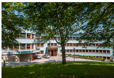
Internat : façade antérieure. Phot. Jérôme Mongreville IVR43_20143900526NUC4A
