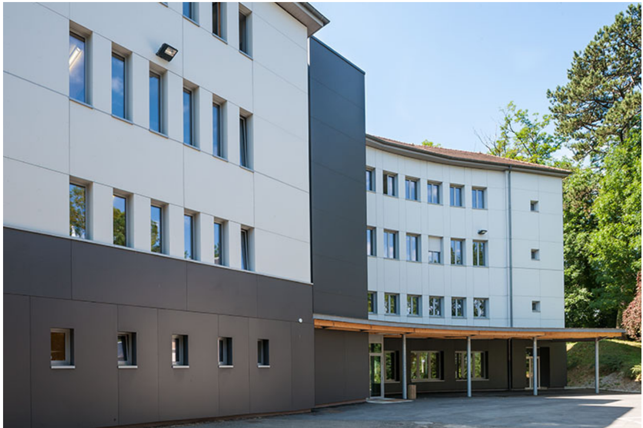
Externat : aile ouest , façade antérieure.
