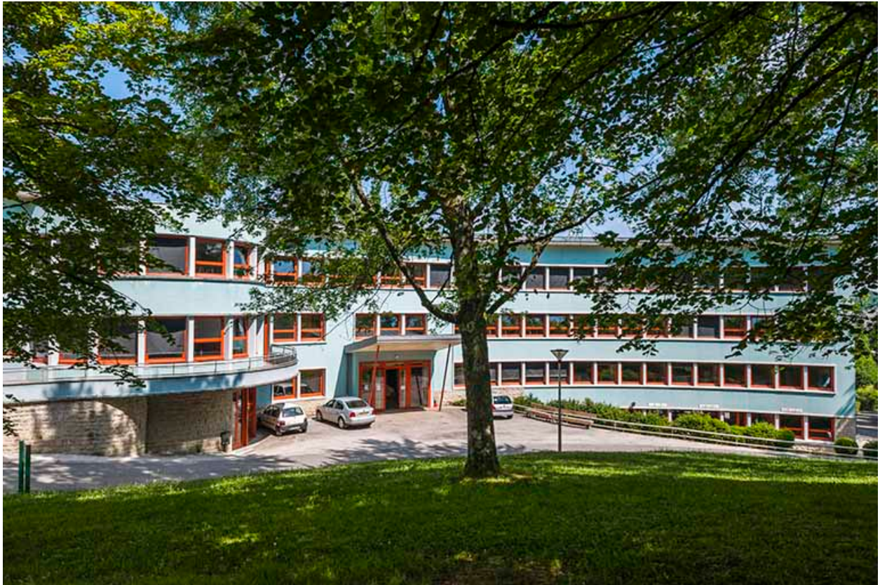
Internat : façade antérieure.
