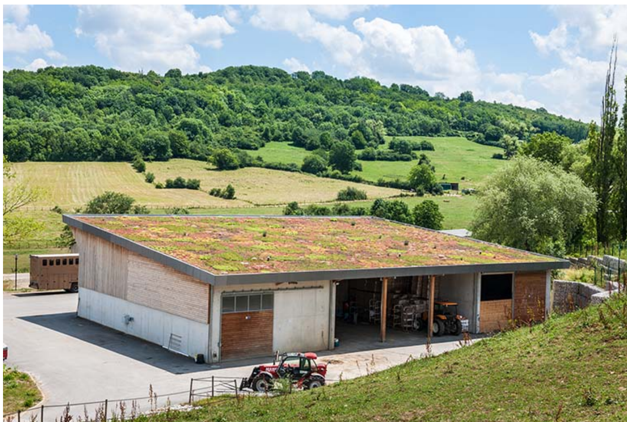
Centre équestre : hangar
