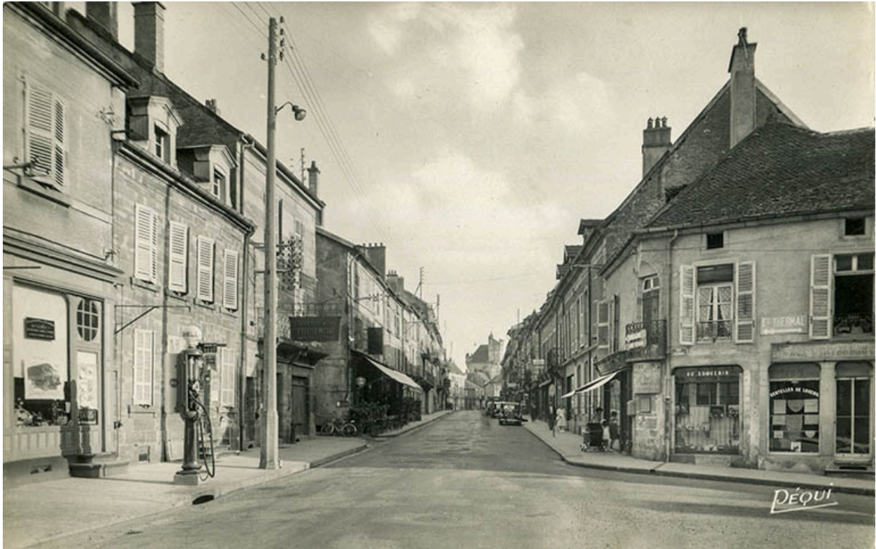
Vue de la rue Carnot.
