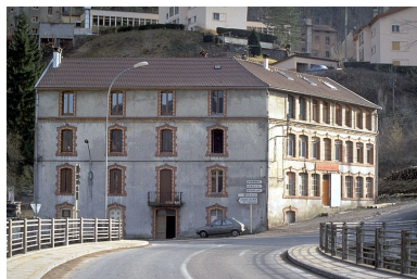
Vue d'ensemble depuis le nord. Phot. Laurent Poupard IVR43_19923901413ZA
