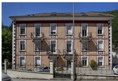
Façade antérieure. Phot. Yves Sancey IVR43_20103900420NUC2A
