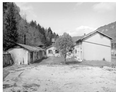
Logement et atelier de réparation. Au premier plan, emplacement du gazomètre. Phot. Jérôme Mongreville IVR43_19923900321X
