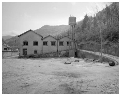
Cour, atelier de fabrication et château d'eau.
