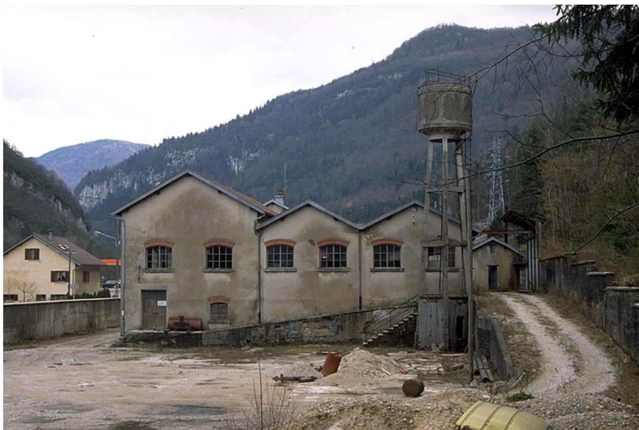
Cour, atelier de fabrication et château d'eau.
