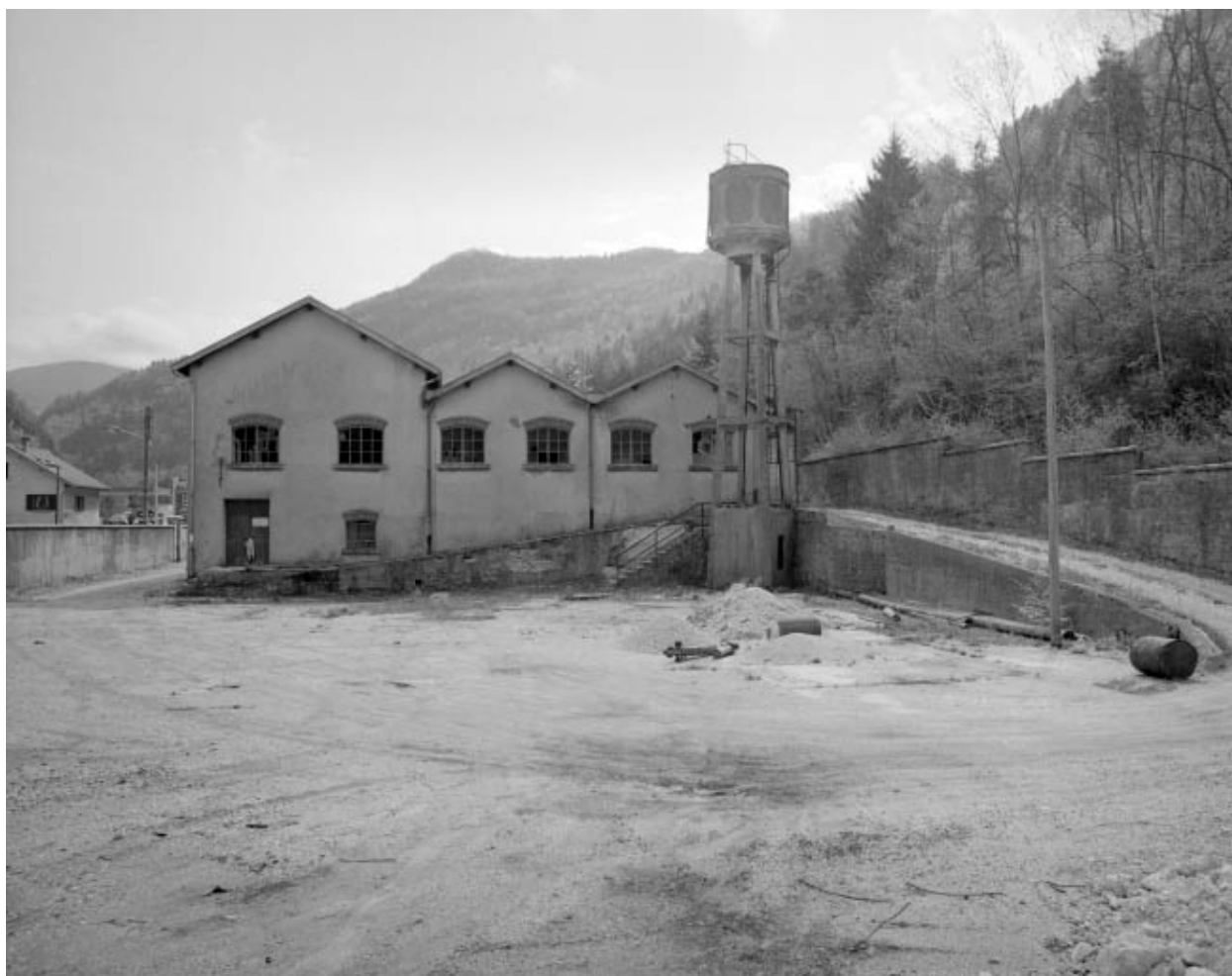
Cour, atelier de fabrication et château d'eau.
