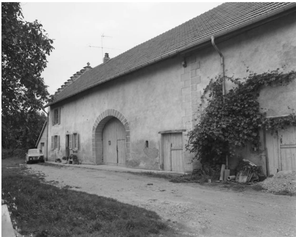
Vue d'ensemble de la façade antérieure.
