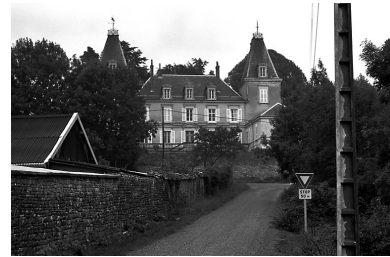
Façade antérieure. Phot. Dominique Dominguez IVR43_19807000510X
