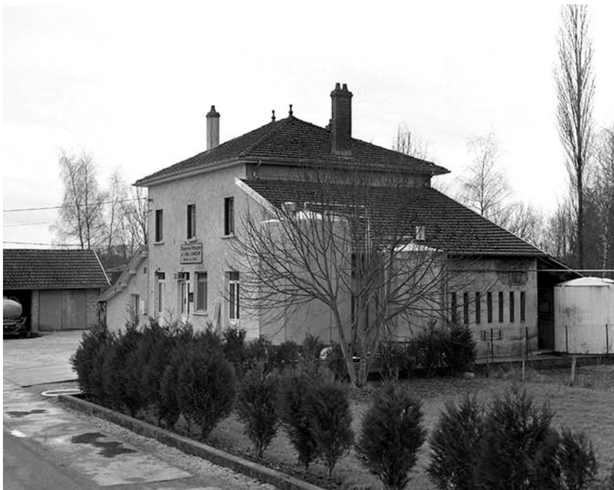
Vue rapprochée depuis la rue.
