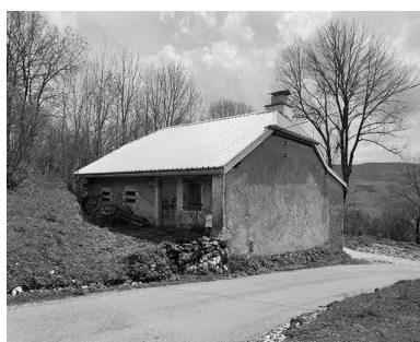
Fromagerie située au lieudit Les Mouillés. Phot. Yves Sancey IVR43_19993900213X
