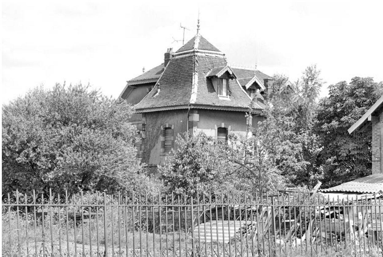
Toitures du logement patronal.
