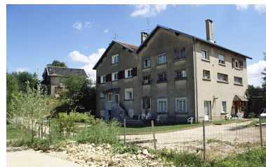
Façade postérieure de la chaudière et salle des machines. Phot. Yves Sancey IVR43_20009000405ZA
