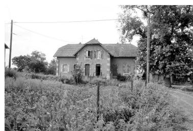
Logement d'ouvriers de la cité en 1980.SRI. Enquête régionale sur les bâtiments industriels (1979-1981).
