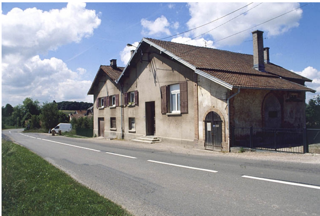
Chaufferie et salle des machines depuis le nord.
