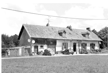
Maison ouvrière à 2 logements. Phot. Yves Sancey IVR43_20009000412X
