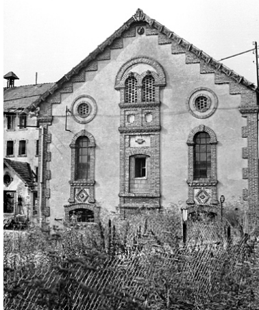
Mur-pignon de la briqueterie (?) vers 1980. Phot. Jérôme Mongreville IVR43_20019000108X
