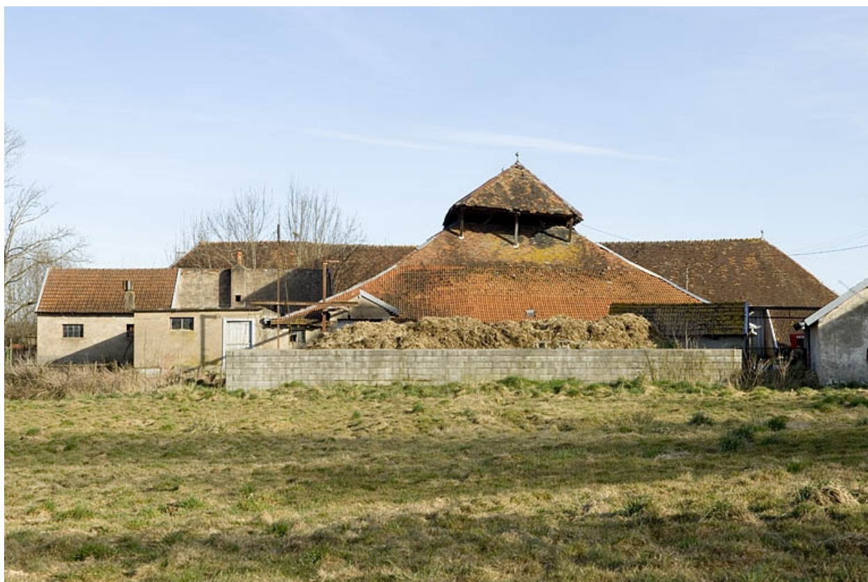
Bâtiment du four et séchoir depuis l'ouest.
