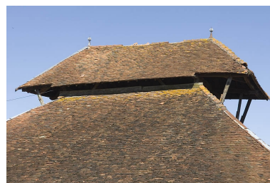
Lanternon du bâtiment du four. Phot. Jérôme Mongreville IVR43_20097000143NUC2A
