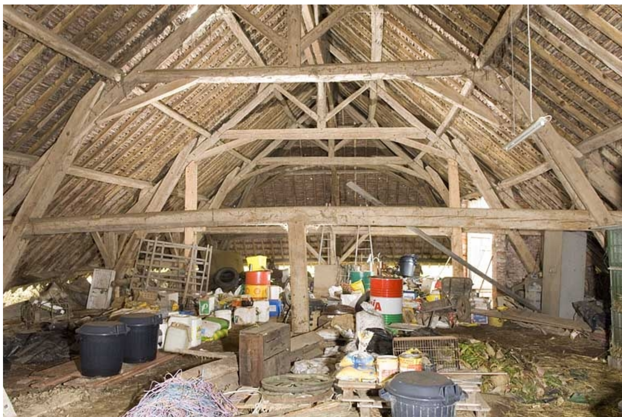
Séchoir. Partie sud de la charpente.
