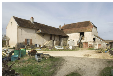
Vue de la ferme depuis l'est. Phot. Jérôme Mongreville IVR43_20097000135NUC2A
