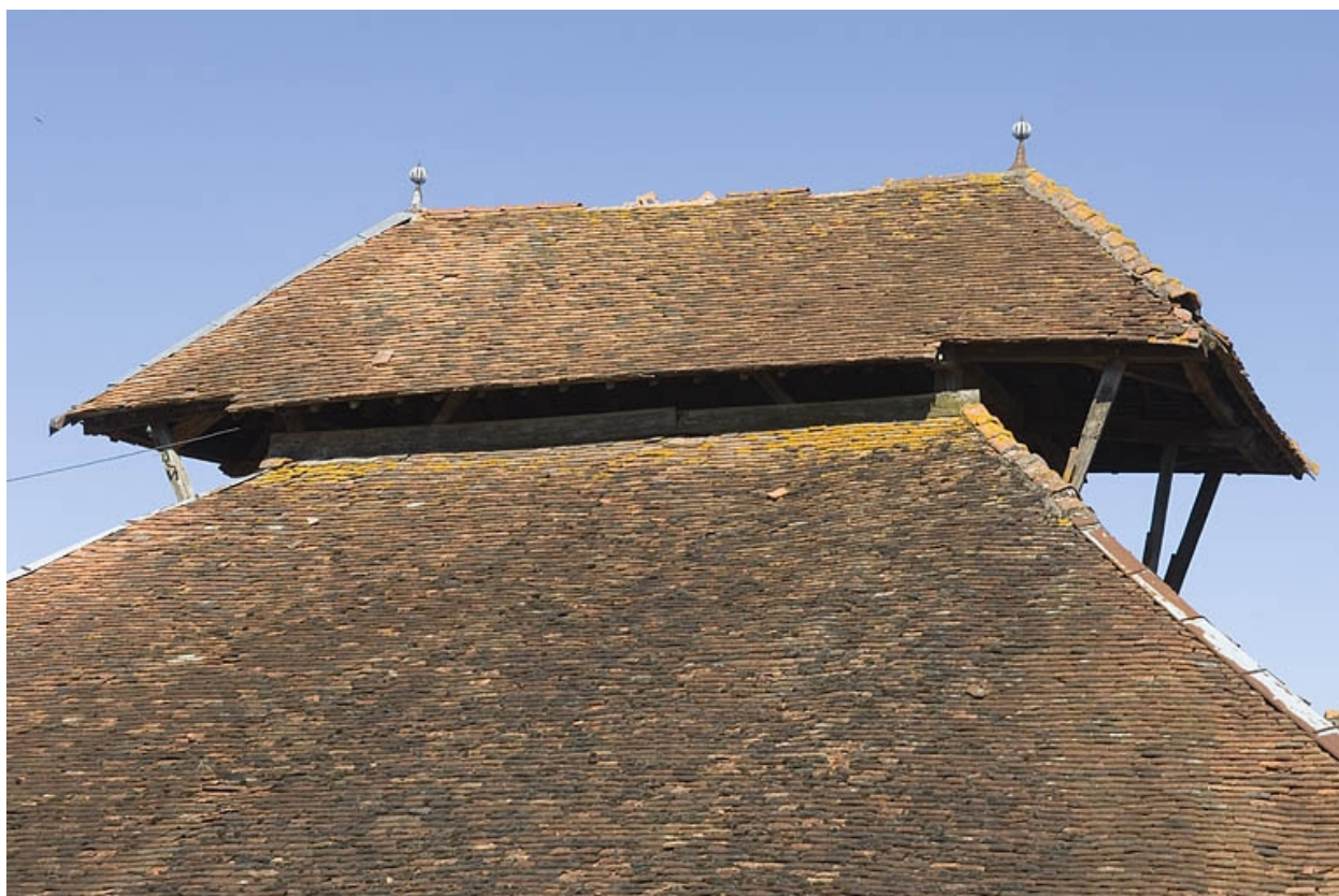
Lanternon du bâtiment du four.
