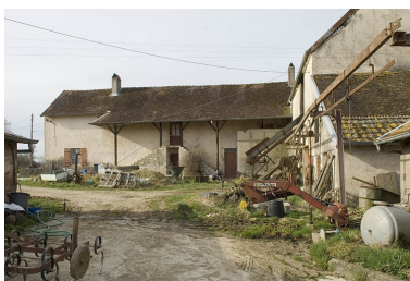
Corps de ferme depuis le nord. Phot. Jérôme Mongreville IVR43_20097000133NUC2A
