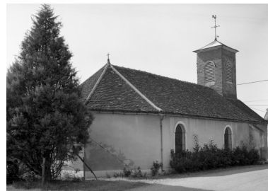
Elévation gauche et chevet Phot. Jean-Luc Duthu IVR26_19852100441V
