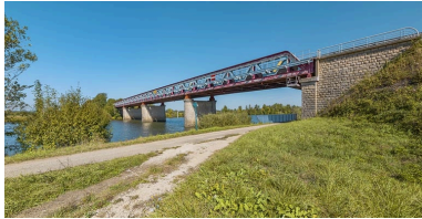
Vue d'ensemble du pont. Phot. Thierry Kuntz IVR26_20192100219NUC4A
