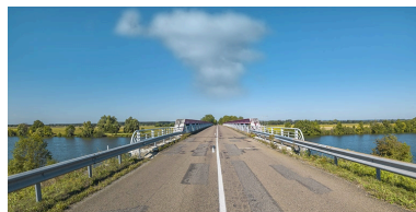
Vue d'ensemble du tablier du pont. Phot. Thierry Kuntz IVR26_20192100223NUC4A
