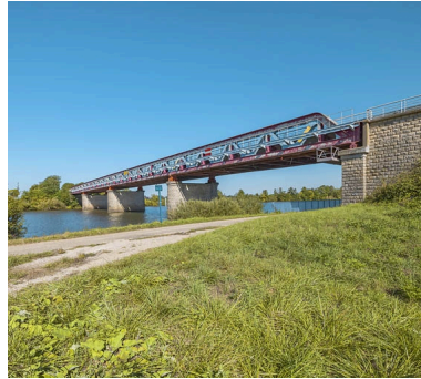
Vue d'ensemble du pont. Phot. Thierry Kuntz IVR26_20192100220NUC4A
