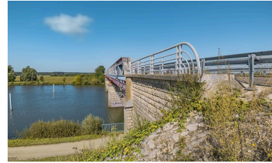
Vue d'ensemble du pont. Phot. Thierry Kuntz IVR26_20192100221NUC4A
