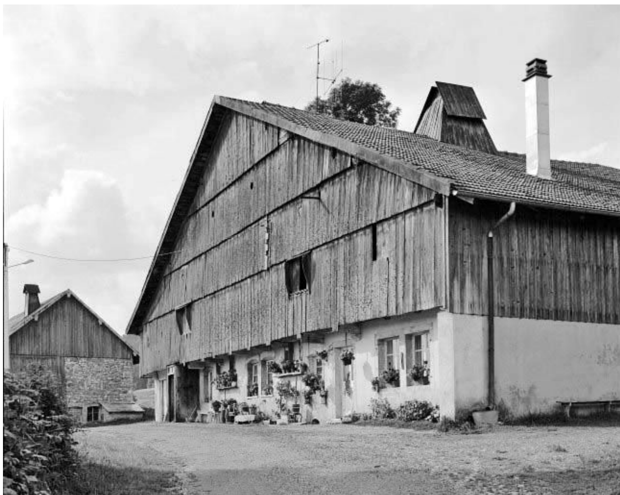
Ferme située au lieudit La Picarde.
