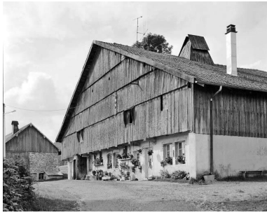
Ferme située au lieudit La Picarde.
