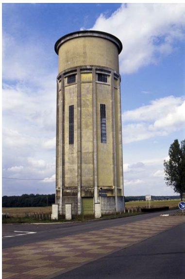
Vue d'ensemble du château d'eau.
