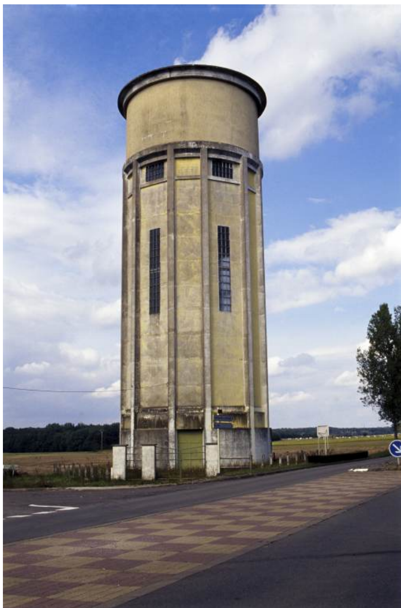
Vue d'ensemble du château d'eau.
