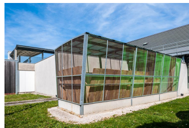
Local de séchage des planches sur la façade ouest. Phot. Jérôme Mongreville IVR43_20143900128NUC4A
