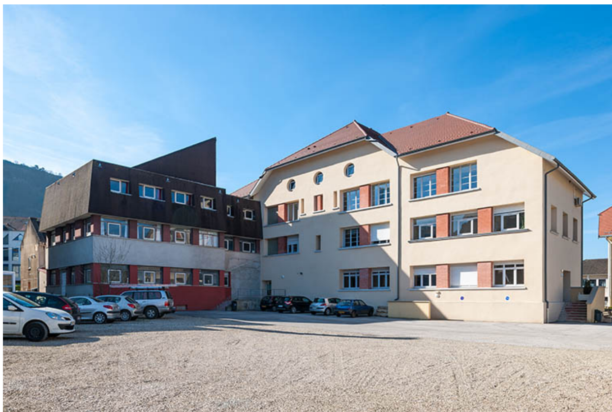
Cour intérieure, angle nord-est de l'école et façade nord de l'extension est.
