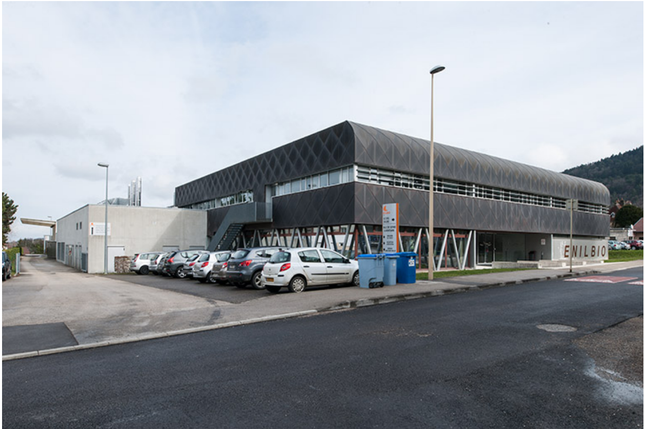
Vue sur les façades ouest et sud de la halle de génie alimentaire.
