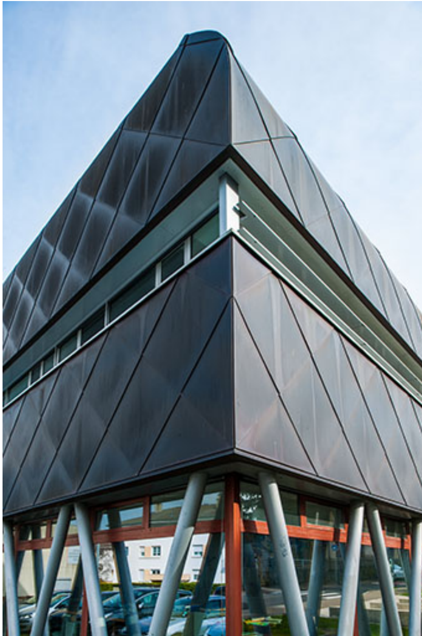
Détail de l'angle sud-ouest de la façade d'entrée sud sur rue de la halle de génie alimentaire.
