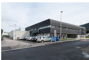
Vue sur les façades ouest et sud de la halle de génie alimentaire. Phot. Jérôme Mongreville IVR43_20143900033NUC4A
