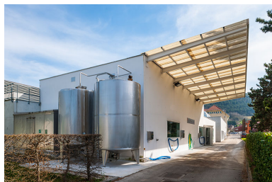
Angle nord-ouest de la halle de génie alimentaire. Phot. Jérôme Mongreville IVR43_20143900124NUC4A
