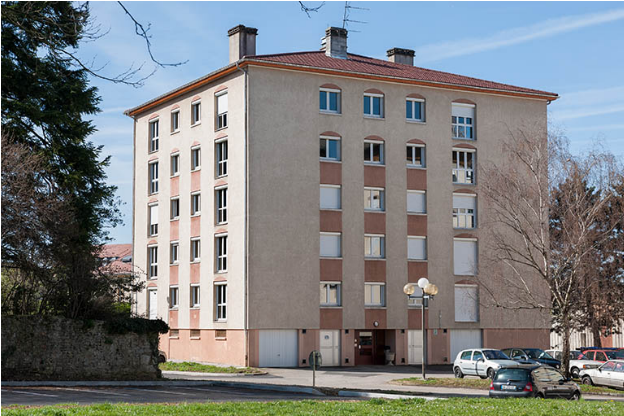
Angle nord-est, entrée du bâtiment des pinsons.
