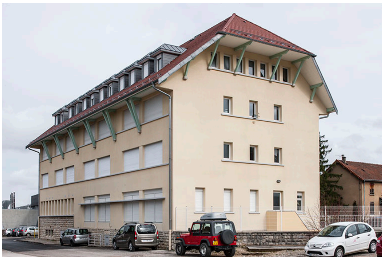
Angle sud-ouest et pignon sud de l'internat.
