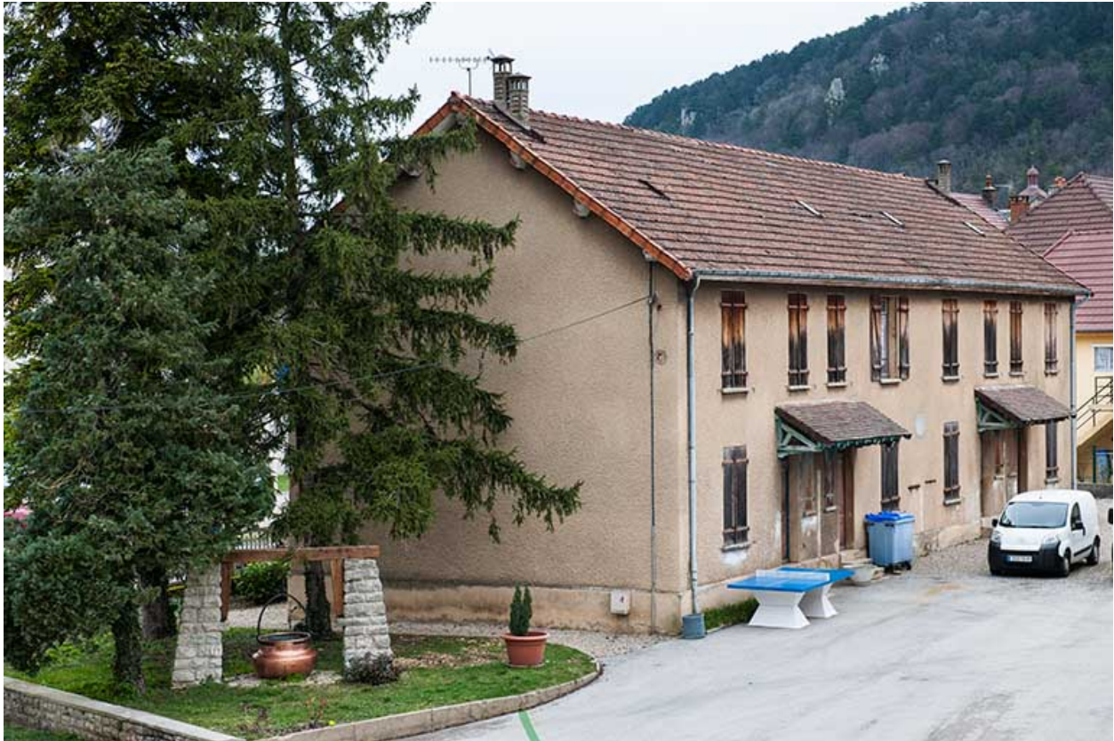
Chaudière à potence devant le pignon ouest de l'annexe (atelier logement).
