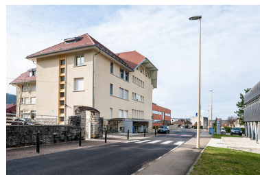
Façade nord de l'internat sur la rue du vieil hôpital. Phot. Jérôme Mongreville IVR43_20143900020NUC4A
