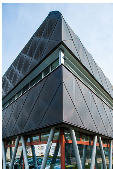
Détail de l'angle sud-ouest de la façade d'entrée sud sur rue de la halle de génie alimentaire. Phot. Jérôme Mongreville IVR43_20143900031NUC4A
