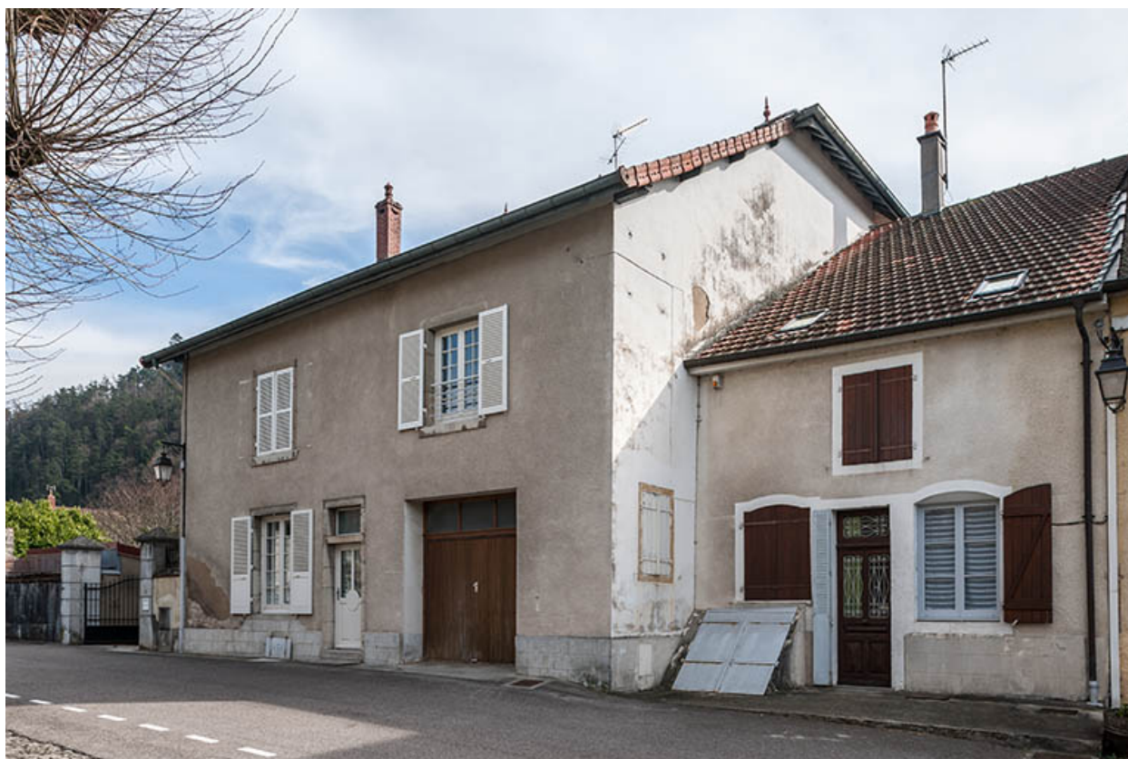
Angle nord-ouest de la façade sur rue de la maison de fonction, 9 place Notre Dame.
