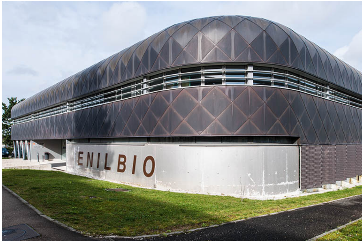
Angle sud-est et façade d'entrée sud sur rue de la halle de génie alimentaire.
