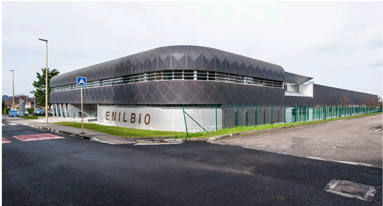
Vue sur les façades est et sud de la halle de génie alimentaire.
