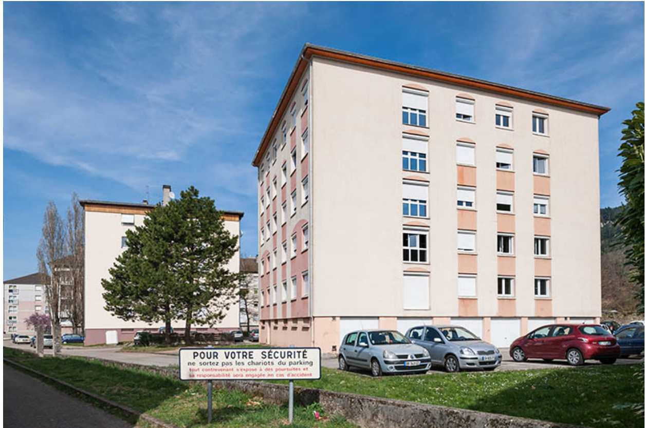
Angle sud-ouest du bâtiment des pinsons.
