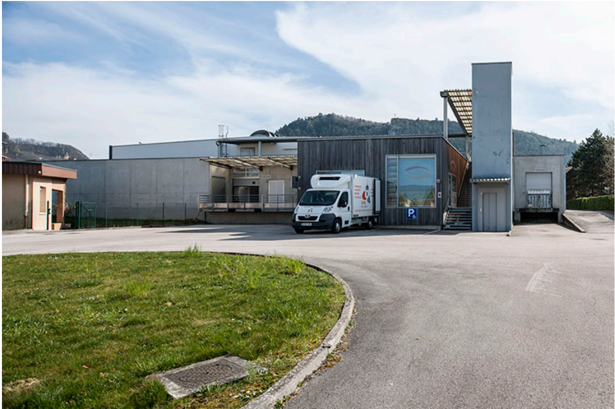
Angle d'une des deux villas de fonction et entrée nord de la halle de génie alimentaire avec sa tour d'ascenseur.
