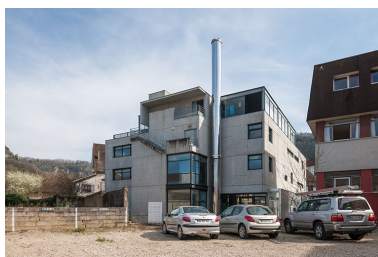
Façade nord de l'extension est de l'école et pignon nord de Cécailat.
