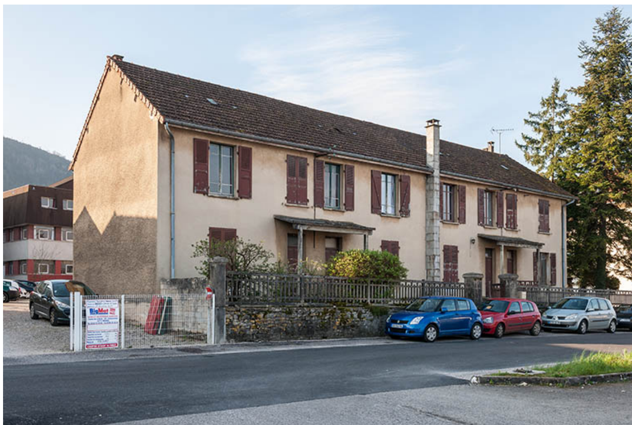
Façade antérieure nord de l'annexe (logement, atelier) sur la rue du vieil hôpital.
