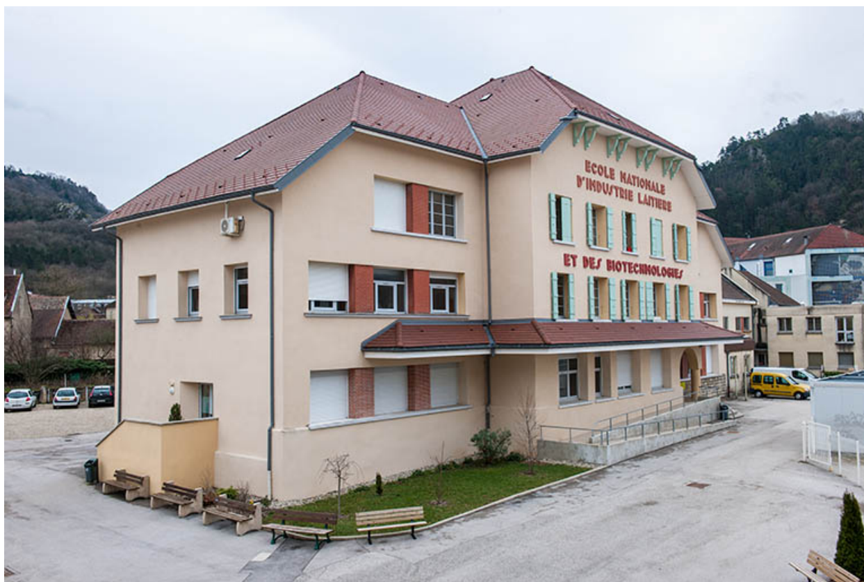
Façade antérieure principale de l'école, angle nord-ouest.
