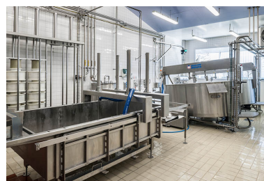
Salle de production des produits frais. Phot. Jérôme Mongreville IVR43_20143900141NUC4A
