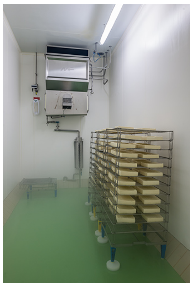
Entreposage de produits frais. Phot. Jérôme Mongreville IVR43_20143900146NUC4A
