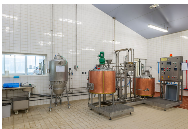
Salle de production des produits frais. Phot. Jérôme Mongreville IVR43_20143900134NUC4A
