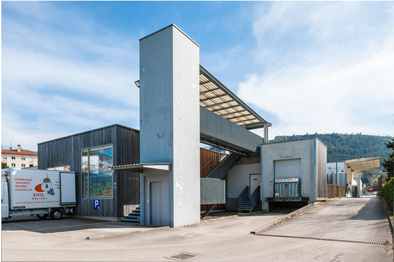
Tour d'ascenseur sur la face postérieure nord de la halle de génie alimentaire.
