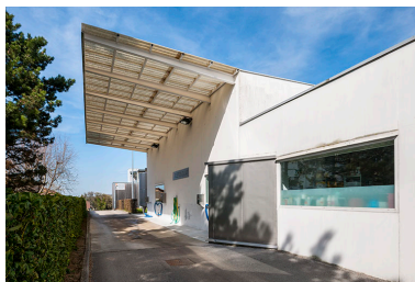
Détail de la façade ouest de la halle de génie alimentaire. Phot. Jérôme Mongreville IVR43_20143900123NUC4A
