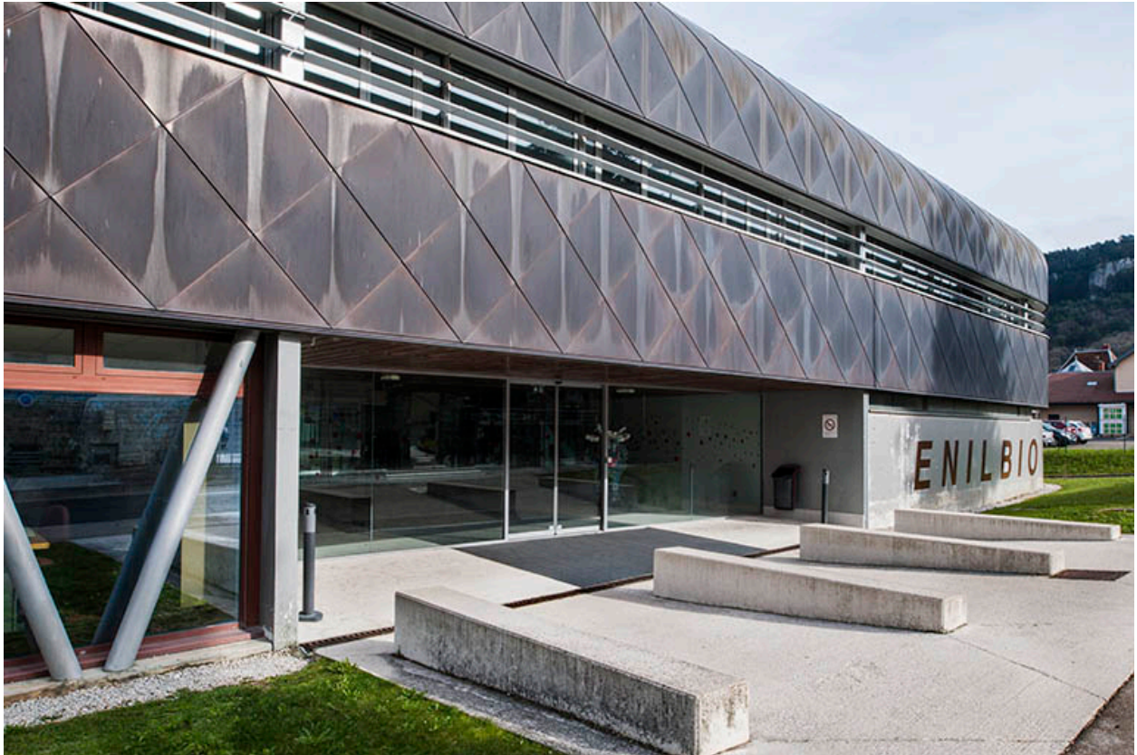
Détail de la façade d'entrée sud sur rue de la halle de génie alimentaire.
