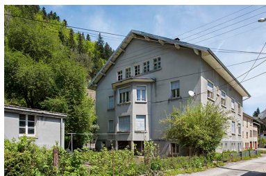
Façade latérale droite, de trois quarts droite.
