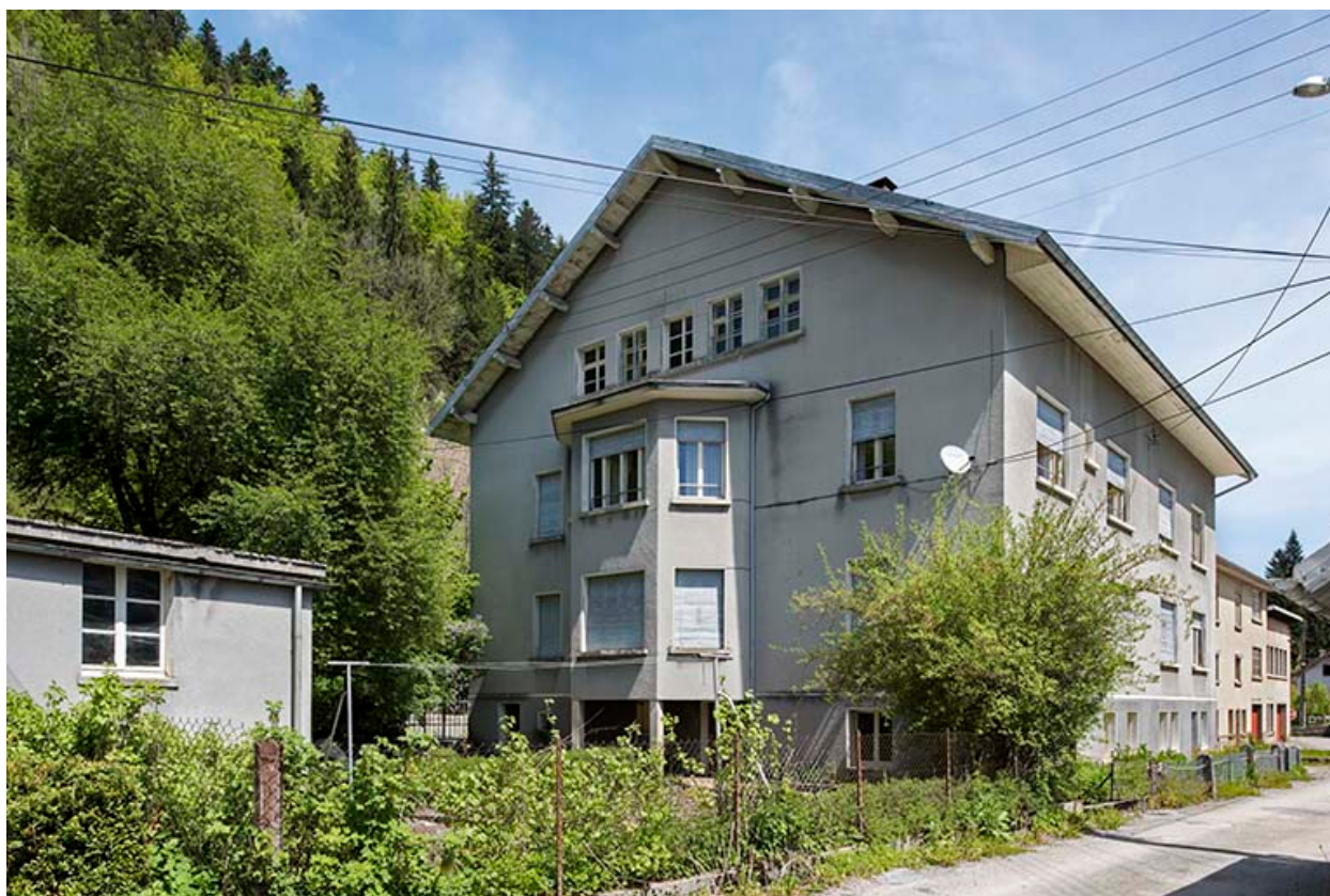
Façade latérale droite, de trois quarts droite.
