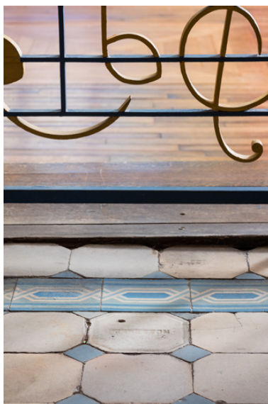
Salle de bal : sol de l'ancienne buvette. Phot. Pierre-Marie Barbe-Richaud IVR26_20257100847NUC4A
