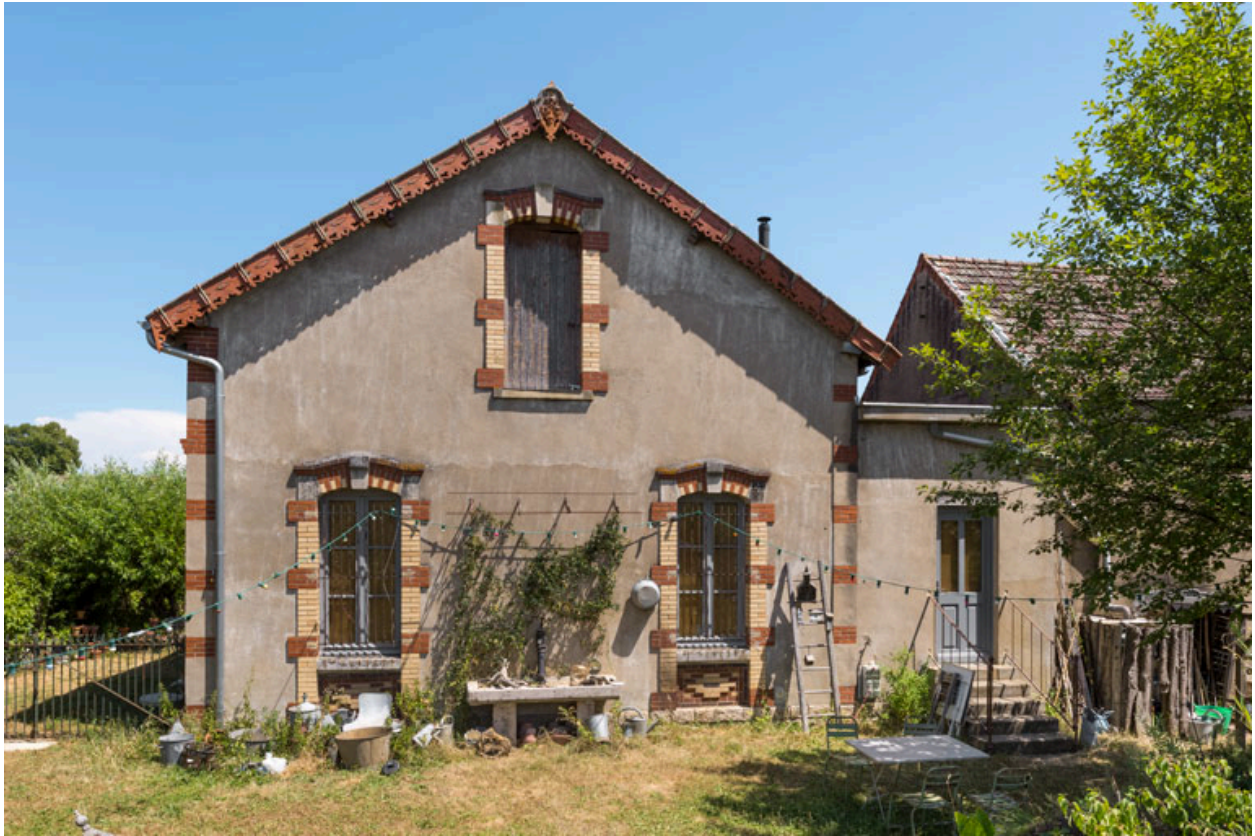
Salle de bal : façade latérale droite.
