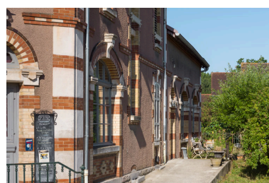
Hôtel-restaurant et salle de bal : façade antérieure, au rez-de-chaussée. Phot. Pierre-Marie Barbe-Richaud IVR26_20257100826NUC4A
