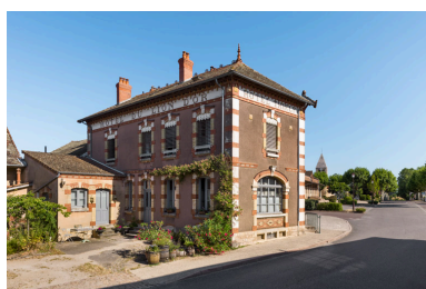
Hôtel-restaurant : façades postérieure et latérale droite. A gauche, la cuisine. Phot. Pierre-Marie Barbe-Richaud IVR26_20257100827NUC4A
