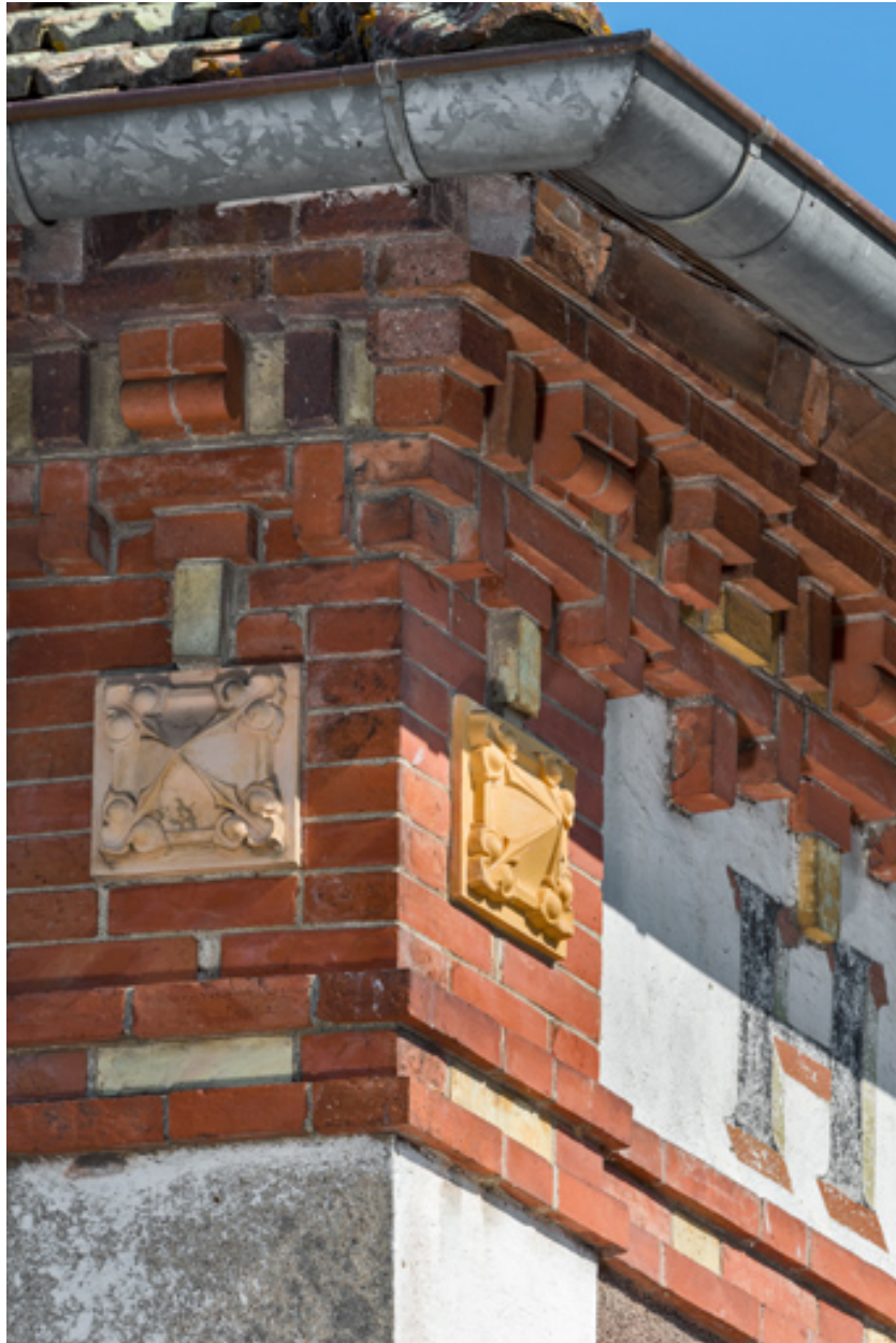
Hôtel-restaurant : décor en partie supérieure des façades postérieure et latérale droite.
