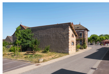
Vue d'ensemble, depuis le sud. Phot. Pierre-Marie Barbe-Richaud IVR26_20257100833NUC4A
