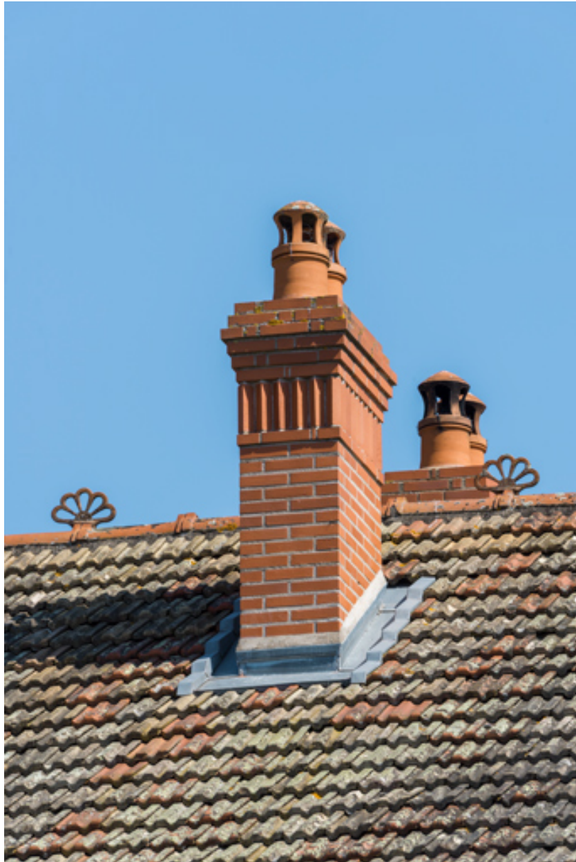
Hôtel-restaurant : souches de cheminée.
