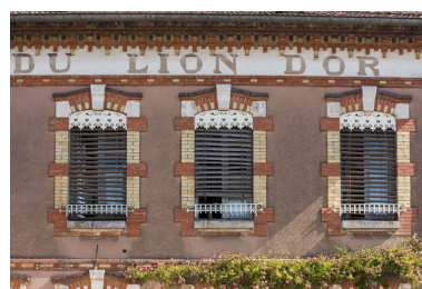
Hôtel-restaurant : façade postérieure, baies à l'étage. Phot. Pierre-Marie Barbe-Richaud IVR26_20257100832NUC4A
