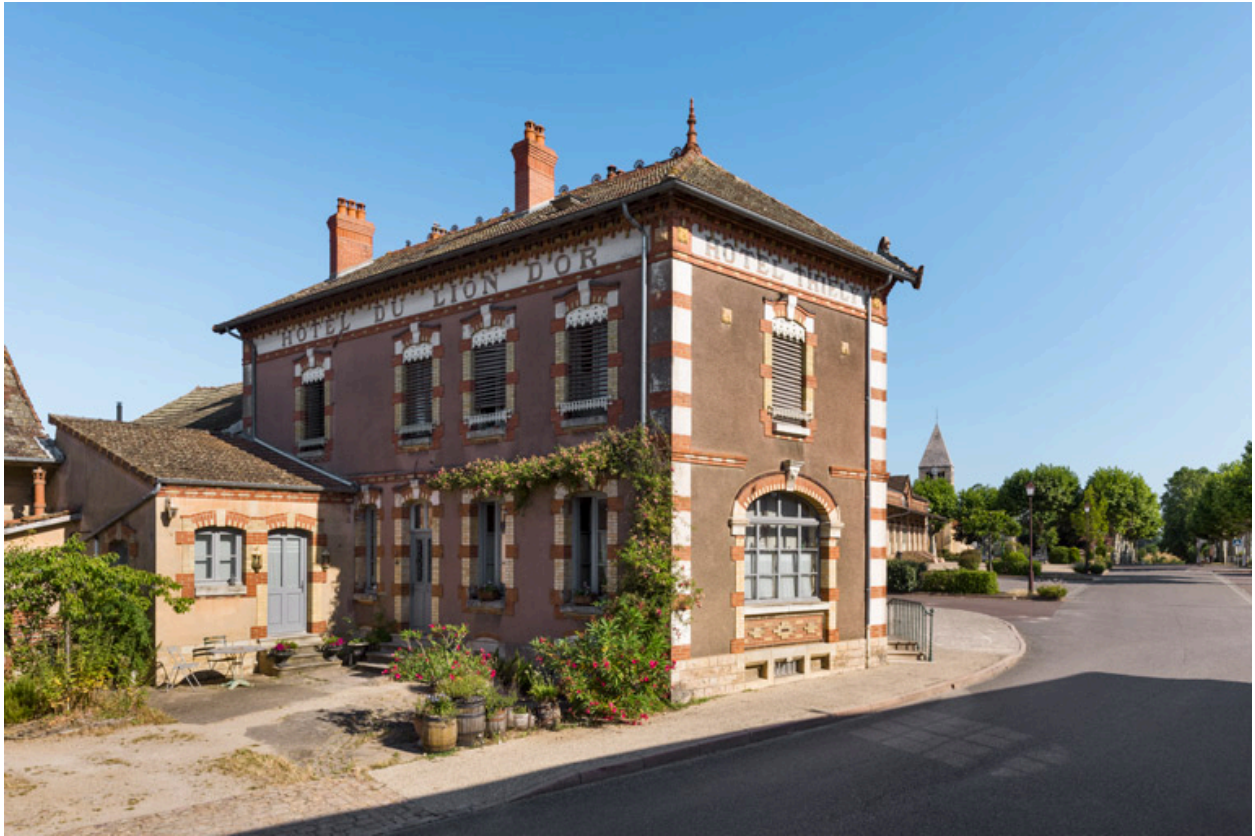
Hôtel-restaurant : façades postérieure et latérale droite. A gauche, la cuisine.
