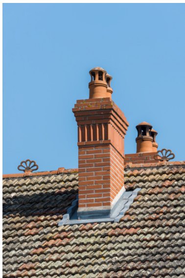
Hôtel-restaurant : souches de cheminée. Phot. Pierre-Marie Barbe-Richaud IVR26_20257100835NUC4A
