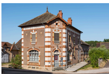
Hôtel-restaurant : façades antérieure et latérale gauche. La salle de bal se trouve à droite. Phot. Pierre-Marie Barbe-Richaud IVR26_20257100825NUC4A
