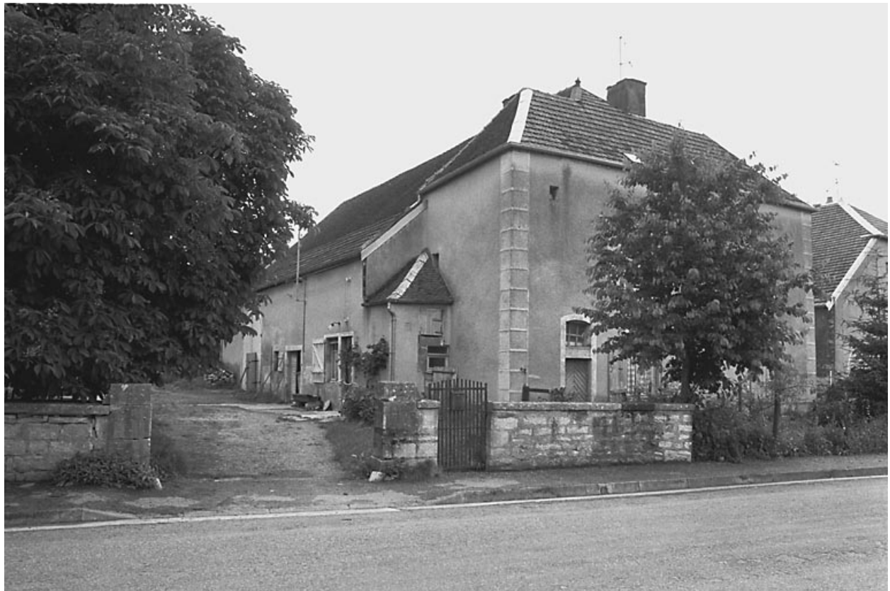
Vue du bâtiment de trois quarts gauche.
