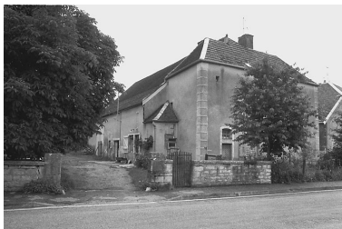
Vue du bâtiment de trois quarts gauche. Phot. Bernard Lardière IVR43_19817000262Z
