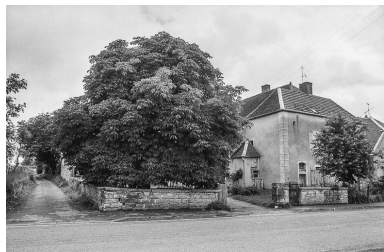
Vue d'ensemble depuis la rue. Phot. Bernard Lardière IVR43_19817000261Z
