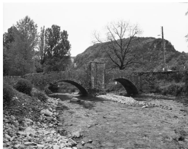
Face aval vue de trois quarts. Phot. Yves Sancey IVR43_19813900222X
