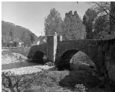
Face aval de trois quarts droit. Phot. Yves Sancey IVR43_19813900220X
