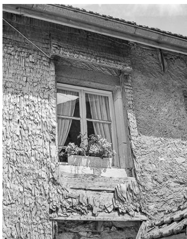
Pan de mur et fenêtre protégés par un essentage en bois. Phot. Dominique Dominguez IVR43_19792500983X
