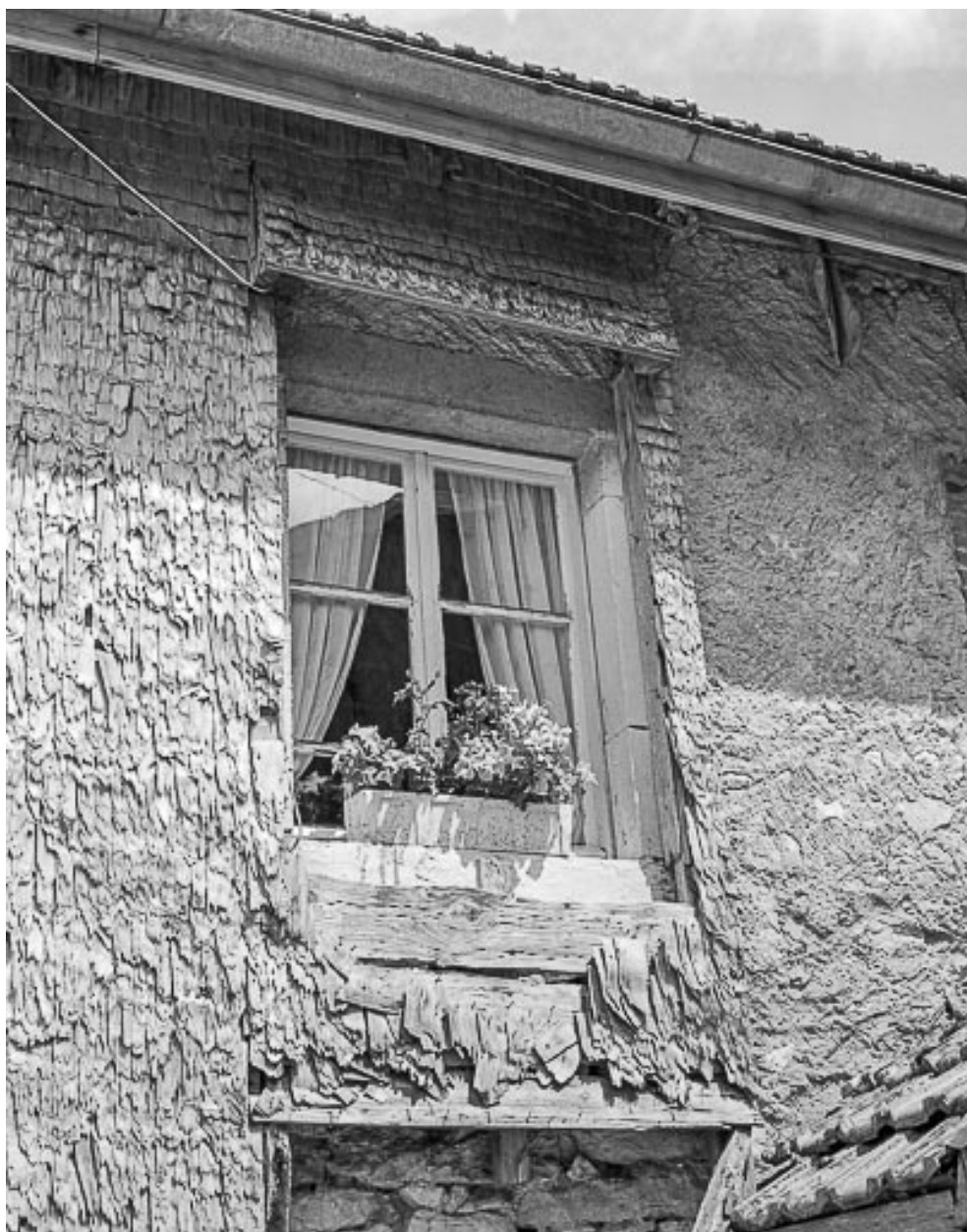
Pan de mur et fenêtre protégés par un essentage en bois.
