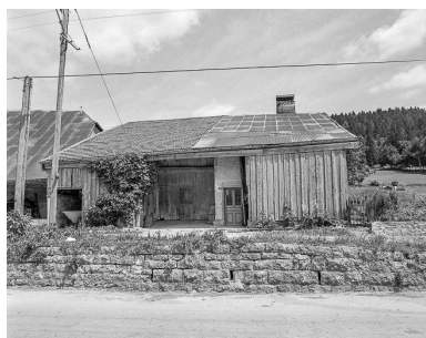
Ferme située rue de la Seigne. Phot. Dominique Dominguez IVR43_19792500979X
