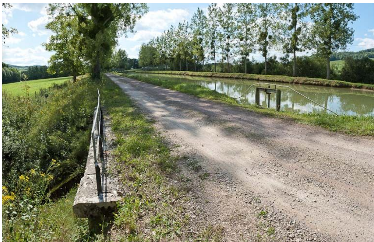
Vue du déversoir.
