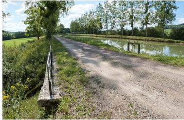
Vue du déversoir. Phot. Pierre-Marie Barbe-Richaud IVR26_20112104006NUC2AQ
