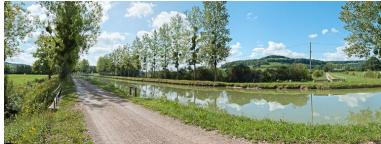
Vue du déversoir. Phot. Pierre-Marie Barbe-Richaud IVR26_20112104004NUC4AQ
