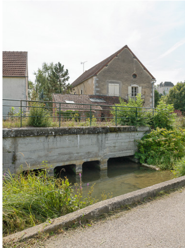
Vue de l'aqueduc. Phot. Pierre-Marie Barbe-Richaud IVR26_20178900081NUC2A
