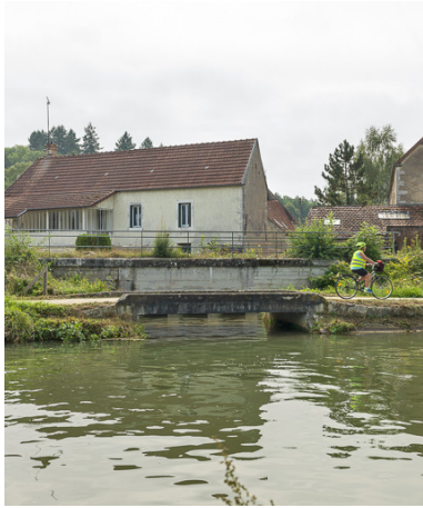
Vue de la rigole. Phot. Pierre-Marie Barbe-Richaud IVR26_20178900080NUC2A
