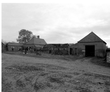
Vue d'ensemble des dépendances nord et est. Phot. Michel Rosso IVR26_20017101332X
