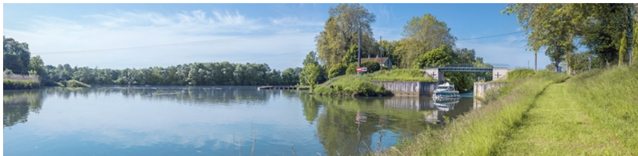
Vue d'ensemble. Bateau sortant de la dérivation d'Heuilley.
