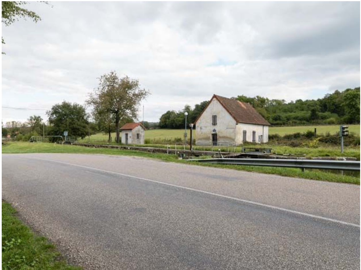
Vue d'ensemble du site d'écluse.
