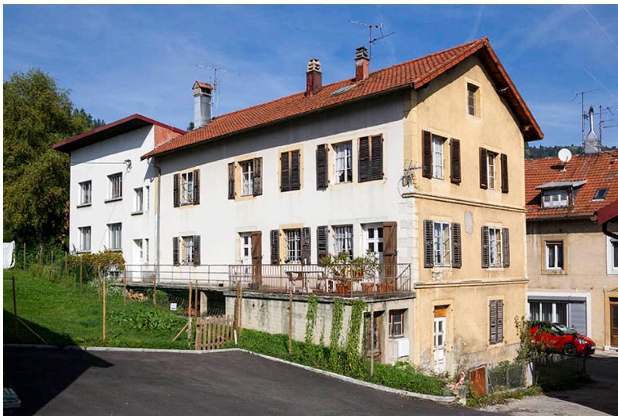
Façades postérieure et latérale gauche.
