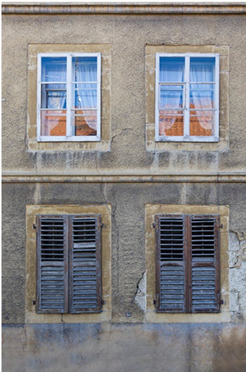
Maison : fenêtre de la façade antérieure.
