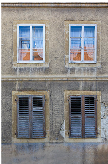
Maison : fenêtre de la façade antérieure.
