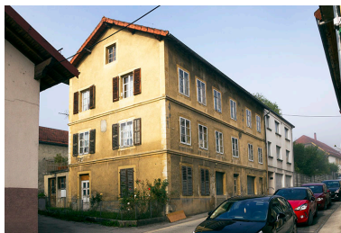
Façades antérieure et latérale gauche.
