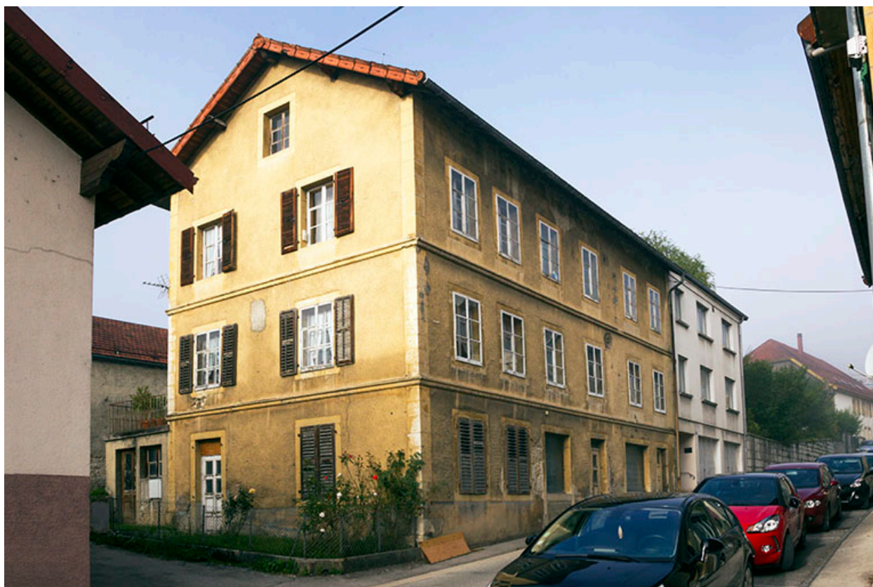
Façades antérieure et latérale gauche.
