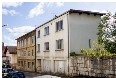
Façades antérieure et latérale droite.
