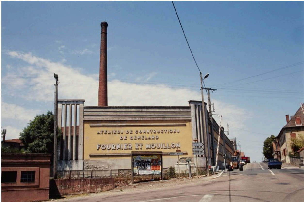
vue g n rale du mur sur le long de la voie de chemin de fer.
