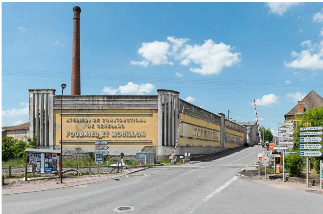
Vue d'ensemble des b timents de l'usine.
