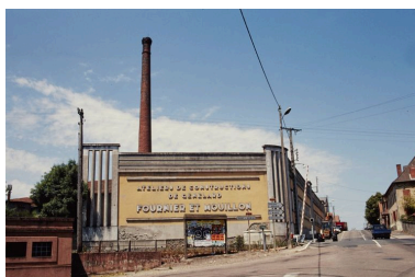
vue g n rale du mur sur le long de la voie de chemin de fer. Phot. Jean-Luc Duthu IVR26_20007100301ZA
