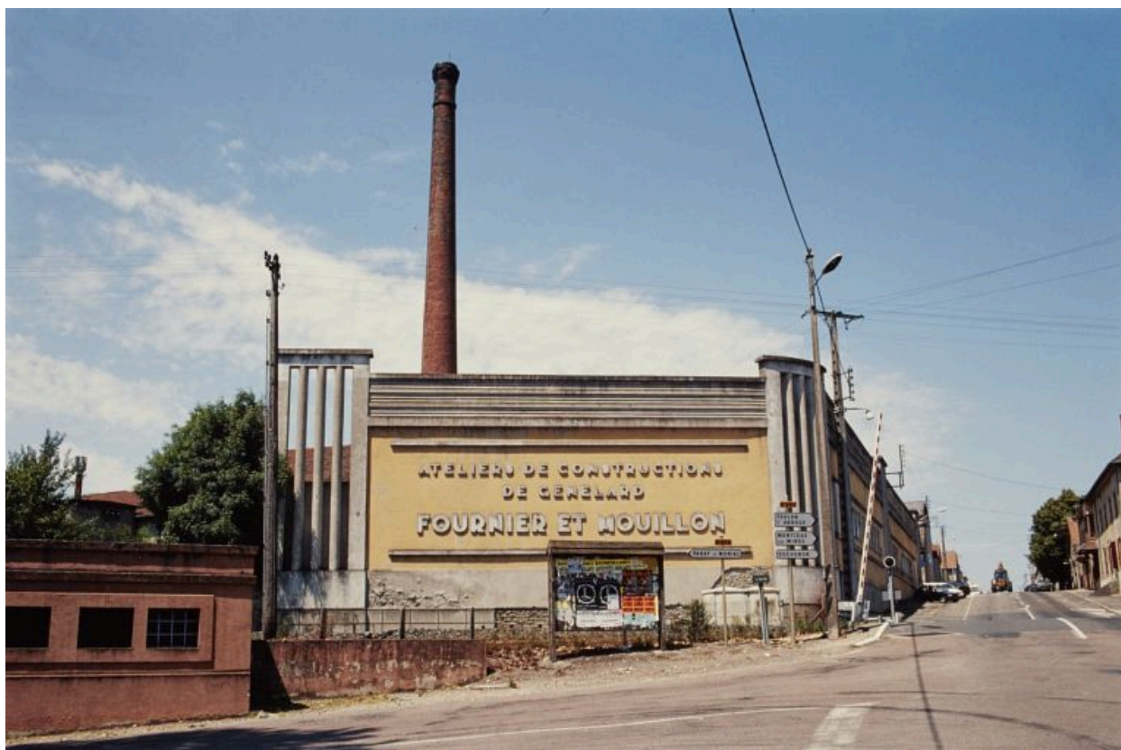
vue g n rale du mur sur le long de la voie de chemin de fer et de la rue Nationale.
