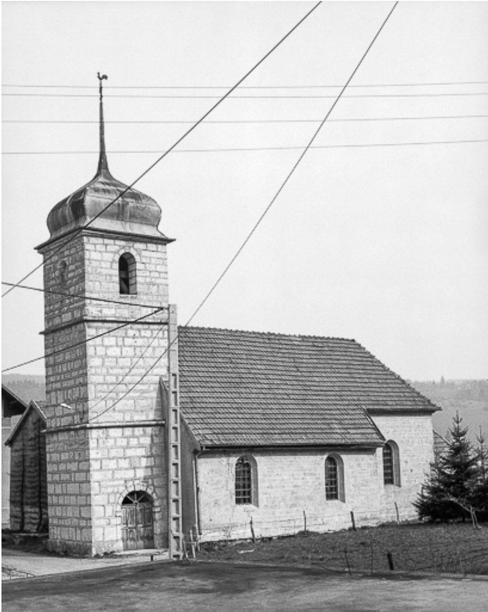
Face sud vue depuis le sud-ouest.
