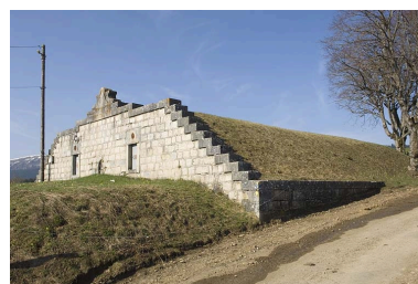
Réservoir du Mont Ramey. Phot. Jérôme Mongreville IVR43_20092500455NUC2A
