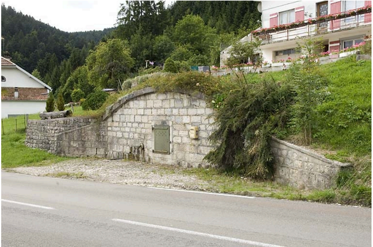
Réservoir des Tavins (route de Vallorbe, 2008 AH 16).
