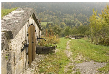
Réservoir des Maillots : façade vue en enfilade. Phot. Jérôme Mongreville IVR43_20082501059NUC2A
