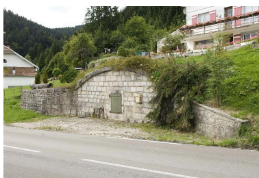
Réservoir des Tavins (route de Vallorbe, 2008 AH 16). Phot. Jérôme Mongreville IVR43_20082500866NUC2A
