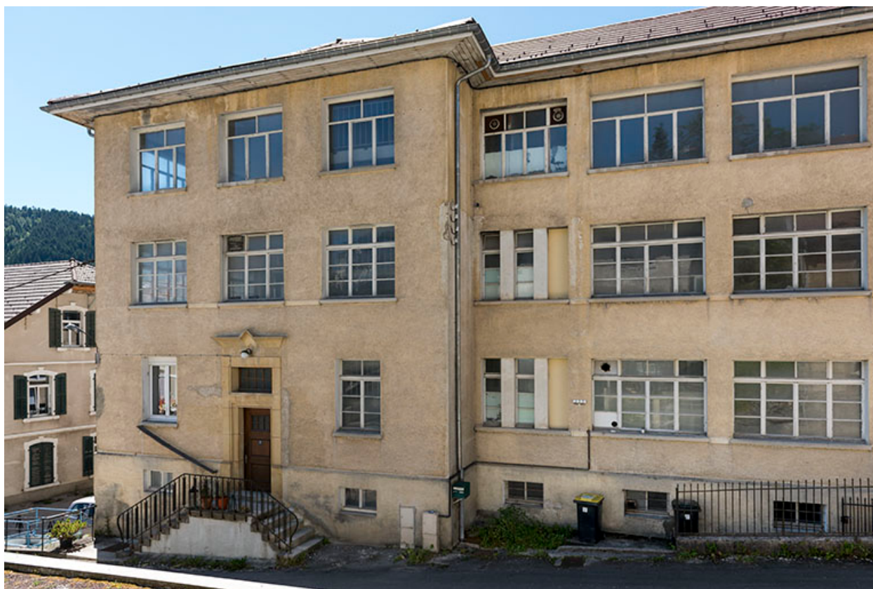
Usine : façade antérieure.
