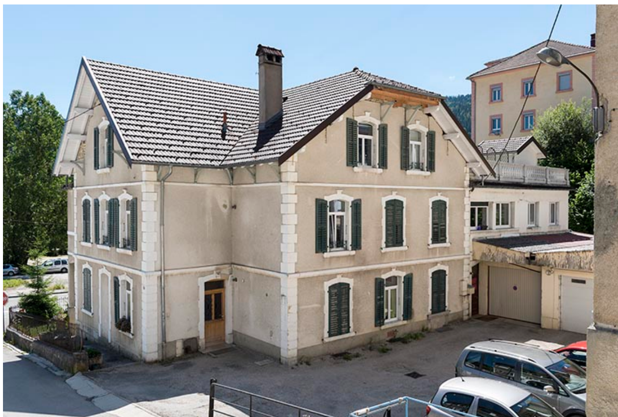
Maison : façades postérieure et latérale droite.
