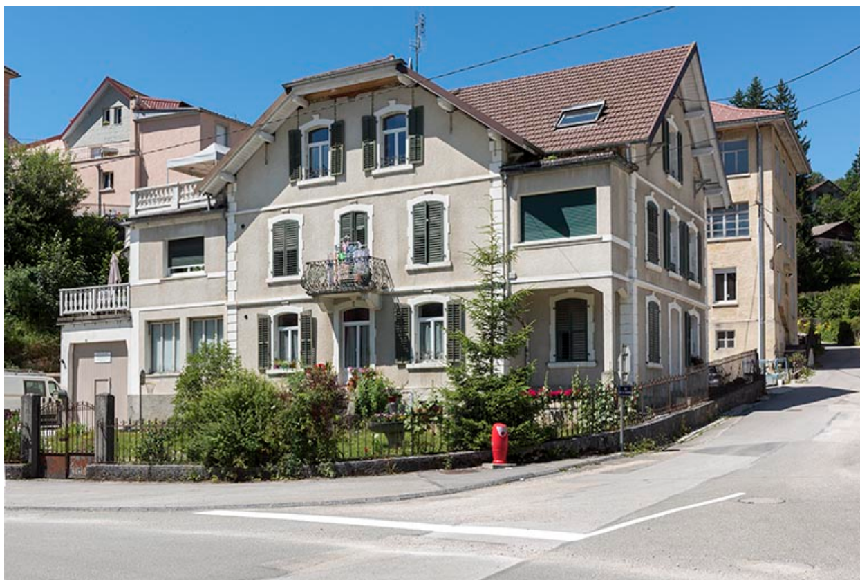
Vue d'ensemble, depuis l'est (maison au premier plan, usine à l'arrière-plan).
